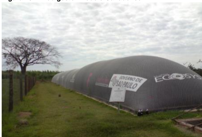
Figura 10 – Biodigestor modelo Canadense
