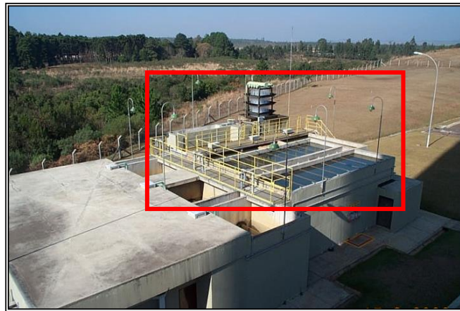
Figura 16: Estação de Tratamento de água Fonte: Indústria de Cerveja estudada, 2014
