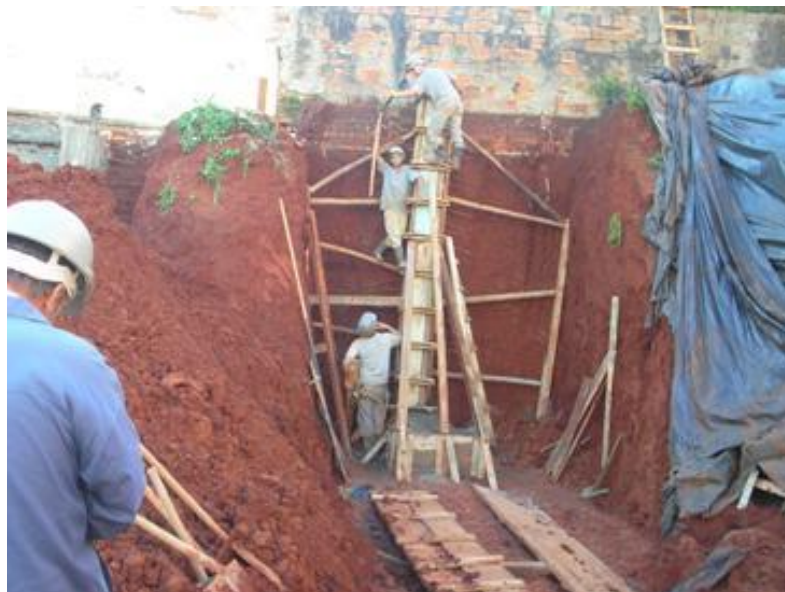
Foto 36 – Execução de cortina de contenção
