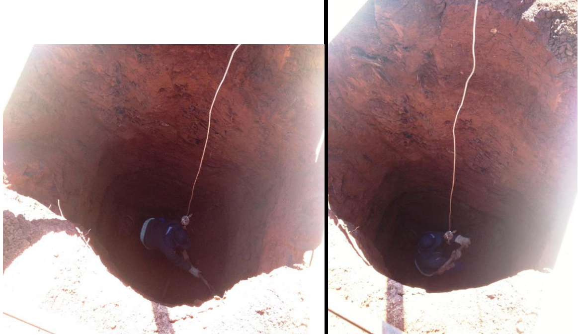
Foto 19 e Foto 20 – Execução do alargamento da base dos tubulões Fonte: a autora
