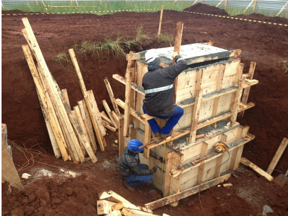
Foto 07 - Execução da forma do bloco de coroamento das estacas
