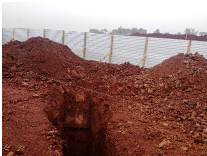
Foto 28 - Material da escavação depositado próximo a borda do tubulão
