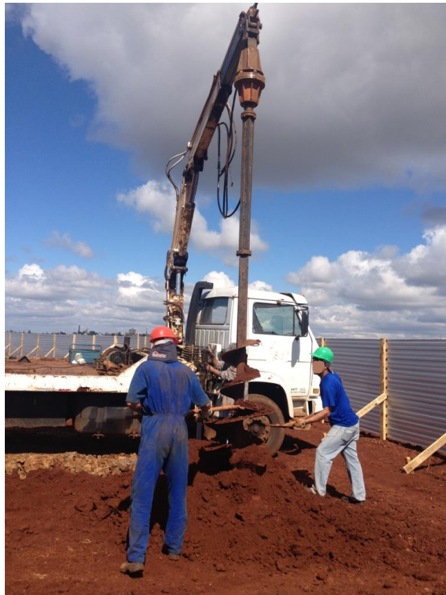
Foto 13 - Escavação do fuste
