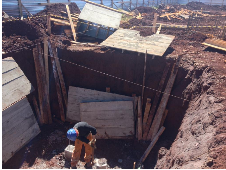
Foto 08 - Funcionário executando atividades dentro da escavação
