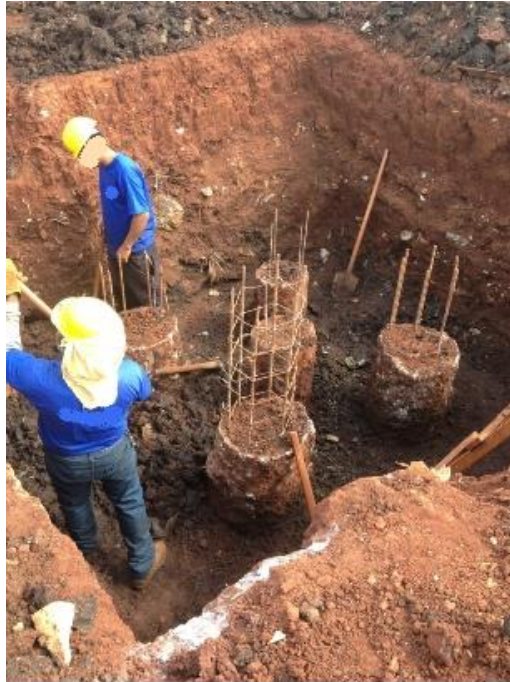
Foto 31 - Escavação dos blocos para o coroamento das estacas
