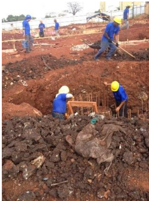
Foto 32 - Escavação dos blocos para o coroamento das estacas
