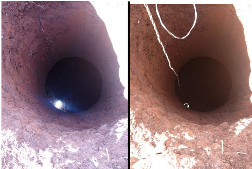
Foto 17 e Foto 18 - Tubulões já com a base alargada
