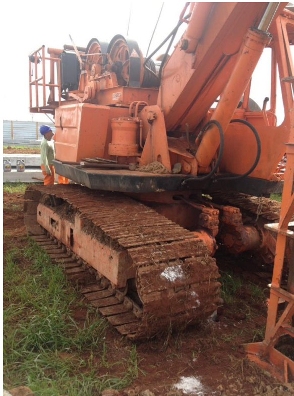
Foto 05 - Vista dos cabos de sustentação do pilão
