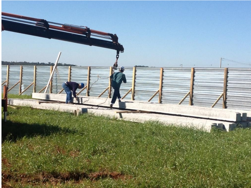
Foto 01- Descarregamento das estacas pré-moldadas no canteiro de obras
