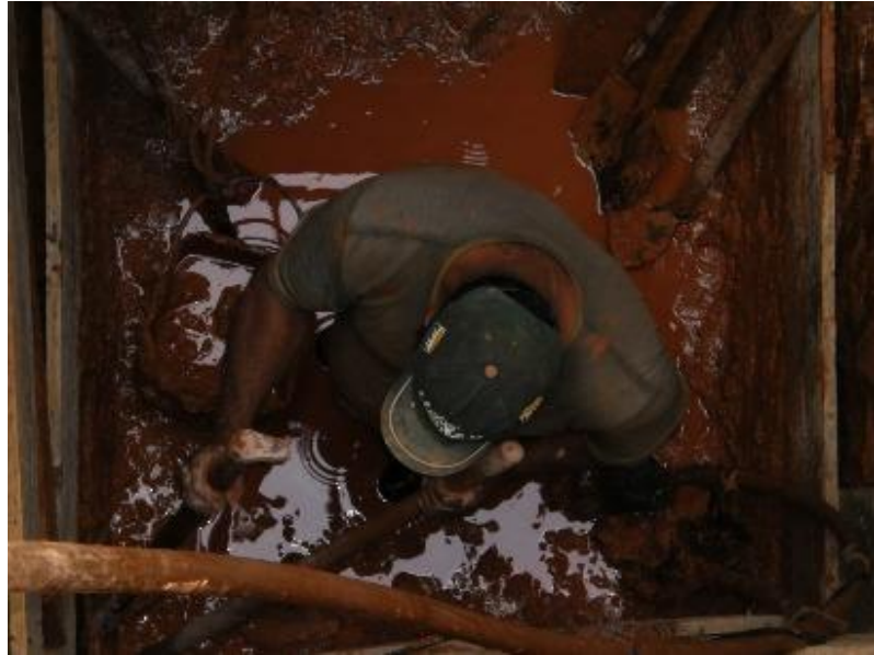
Foto 39 - Escavação de sapata
