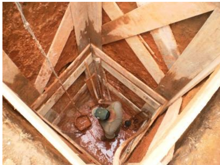
Foto 38 - Escavação de sapata
