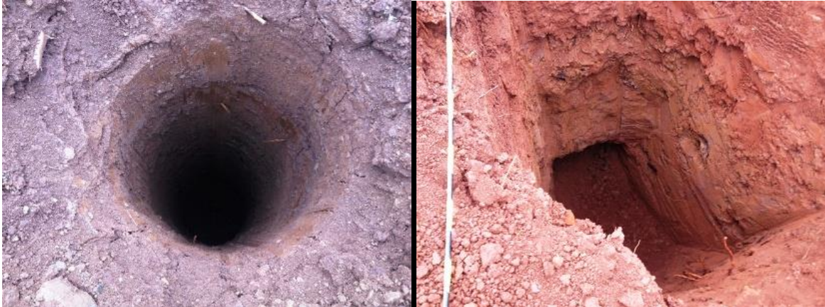
Foto 26 e Foto 27 - Tubulões após muita chuva
