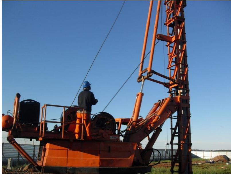
Foto 03 - Cravação de estaca de concreto pré-moldado
