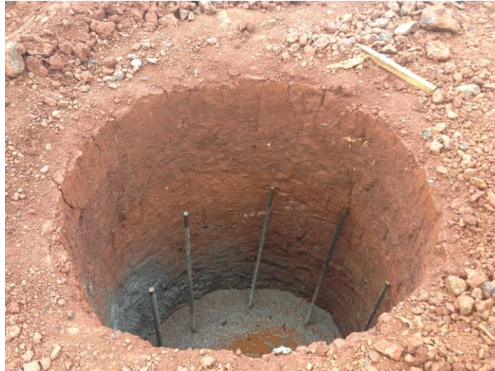
Foto 16 - Tubulão concretado
