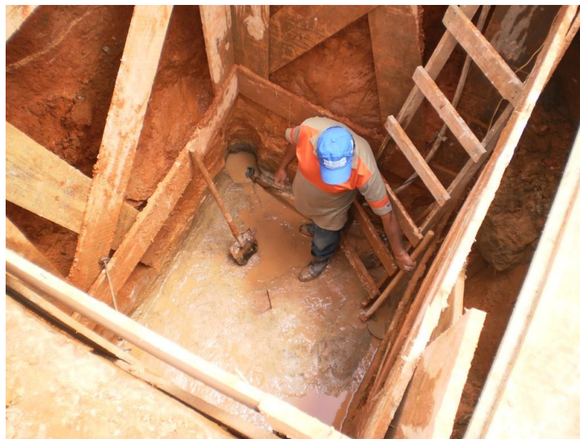
Foto 40 - Escavação de sapata
