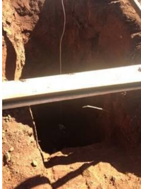
Foto 23 - Talha elétrica mal posicionada
