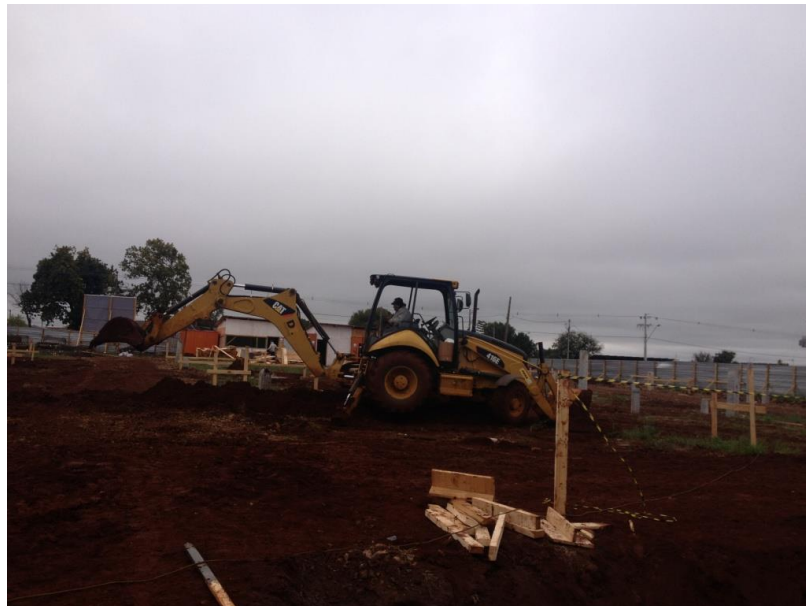
Foto 09 - Escavadeira – movimentação de terra no terreno
