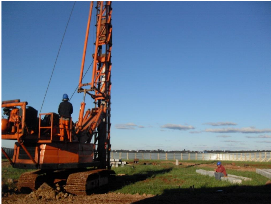
Foto 02 - Cravação de estaca de concreto pré-moldado
