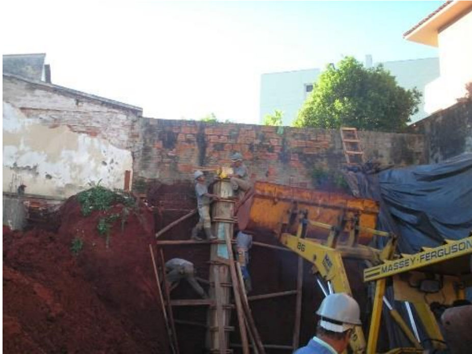
Foto 37 – Execução de cortina de contenção
