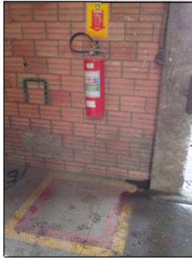
Fotografia 1- Instalação dos extintores Fonte: Autor, 2013
