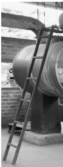
Figura 15 – Foto da escada de acesso as válvulas de segurança
