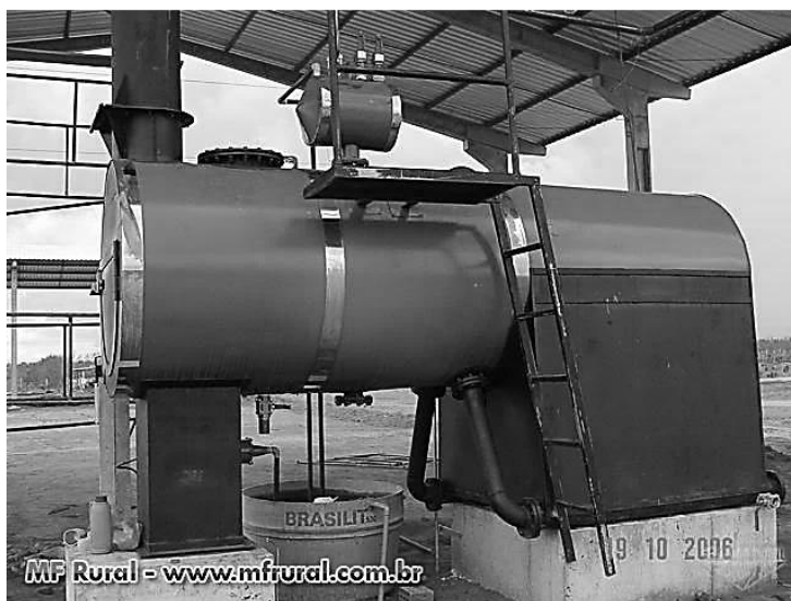
Figura 10 – Caldeira flamotubular mista Disponível em: http://www.mfrural.com.br (acessado em 14/09/2013)
