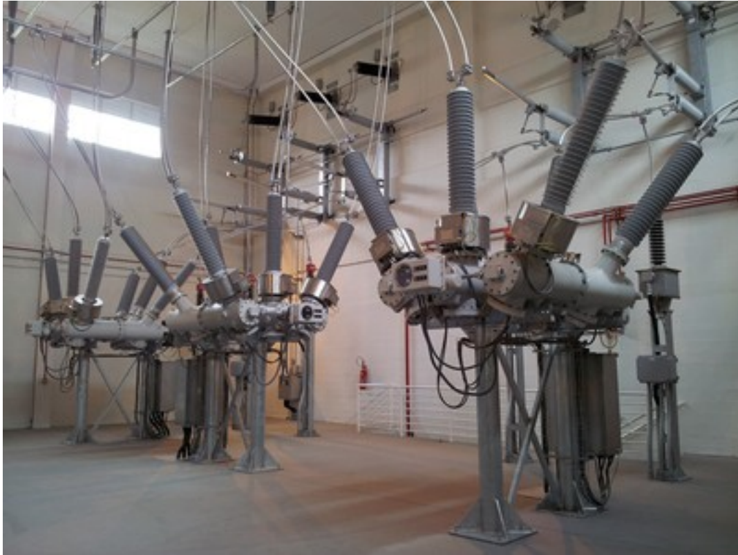
Figura 2 – Subestação Abrigada
