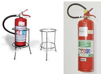
Figura 1 – Extintor colocado em suportes de piso acabado e de parede
