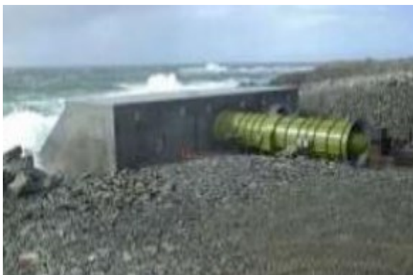
Figura 9 - Conceito de coluna de água oscilante - Limpet - Projeto Escócia
