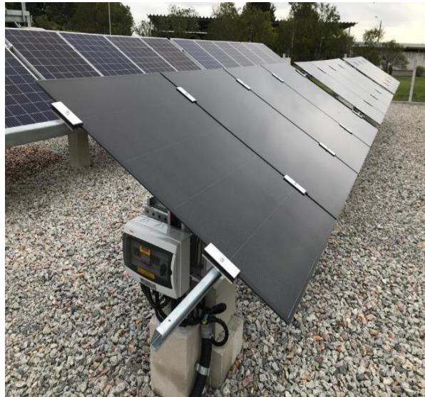
Figura 15 – Tecnologia CIGS: a) módulo fotovoltaico; b) painel fotovoltaico.
