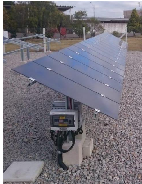
Figura 16 – Tecnologia CdTe: a) módulo fotovoltaico; b) painel fotovoltaico.
