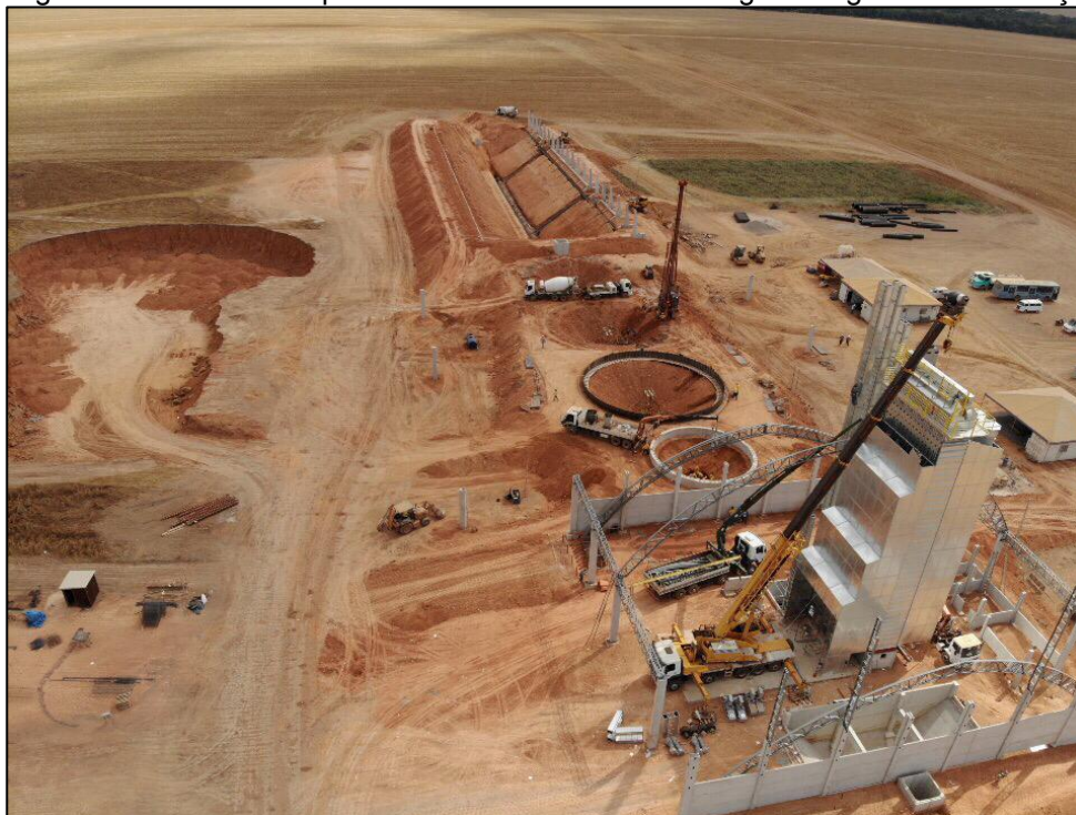
Figura 11 - Unidade de pré-beneficiamento e armazenagem de grãos em execução
