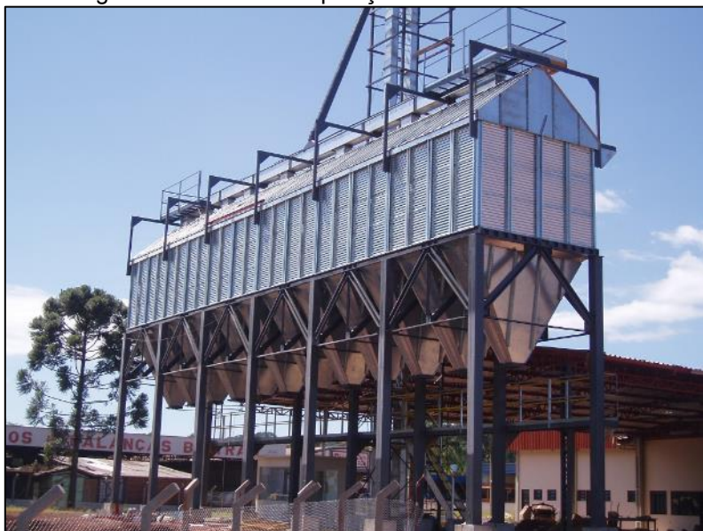
Figura 10 - Tulha de expedição em estrutura metálica
