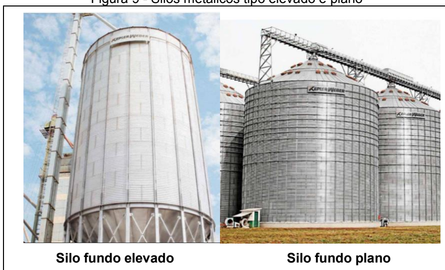
Figura 9 - Silos metálicos tipo elevado e plano
