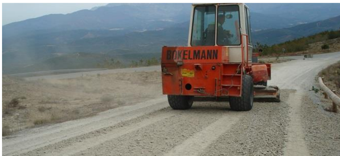
Figura 5 – Distribuição de solo-cimento.
