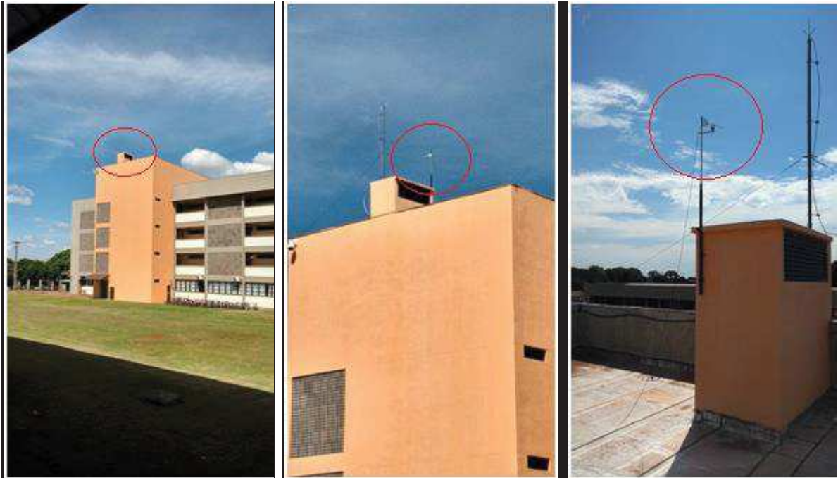
Figura 23 - Local onde o gerador eólico foi instalado para a coleta de dados (bloco C da UTFPR-TD). Fonte: Autoria própria.
