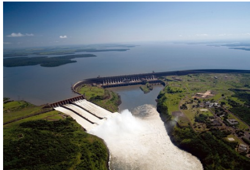
Figura 1- Vista aérea da barragem hidrelétrica de Itaipu, Brasil.
