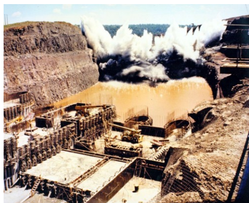
Figura 6 - Explosão de canal.
