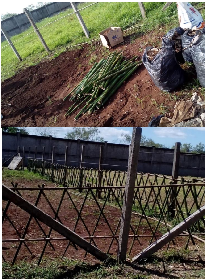
Figura 1: Espaço preparado para instalação da UHorta.
