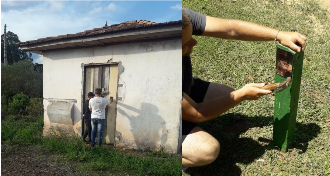
Figura 28: Instalação das placas com QR Code
