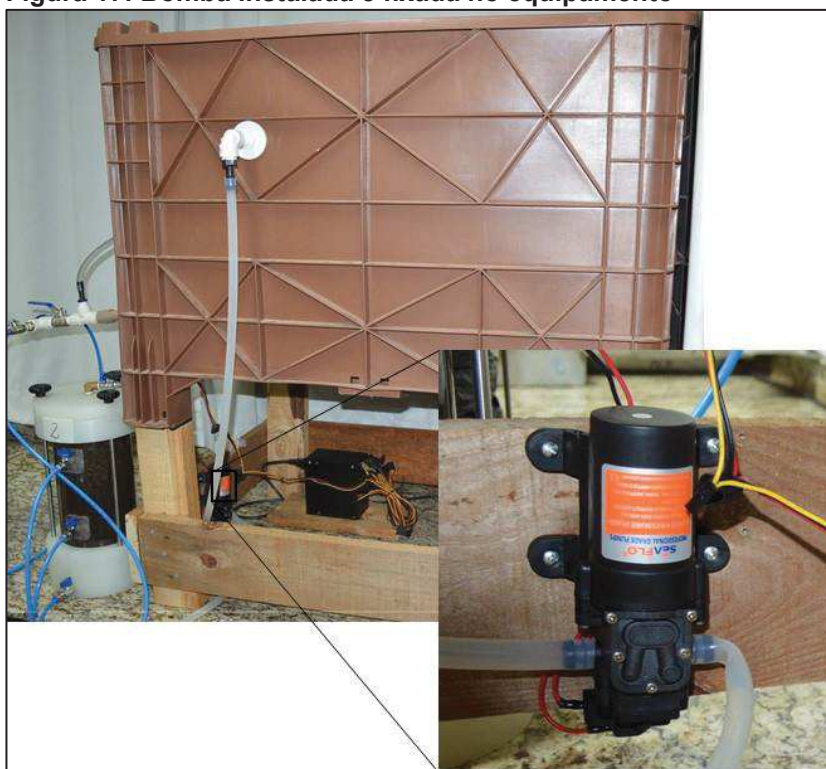
Figura 17: Bomba instalada e fixada no equipamento
