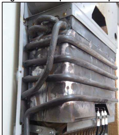
Figura 13 – Serpentina do aquecedor
