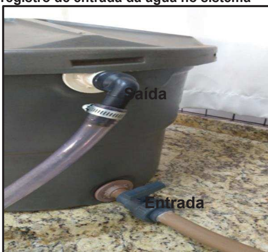
Figura 15 – Tubulações de entrada e saída da água e registro de entrada da água no sistema
