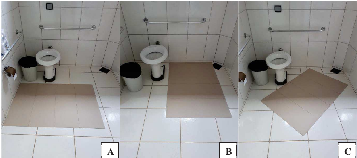
Figura 28 – Sanitário acessível, A – Possibilidade de transferência perpendicular, B – Possibilidade de transferência lateral, C – Possibilidade de transferência diagonal, ESF Jardim Pancera, Toledo – PR.
