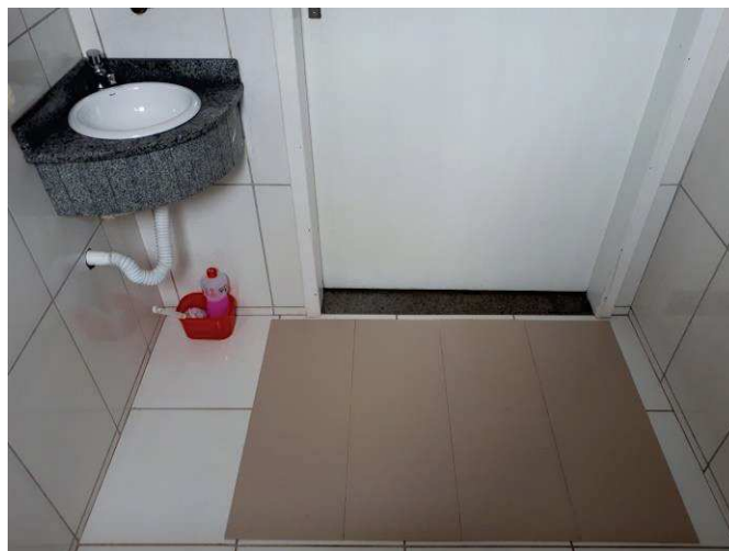
Figura 29 – Área de aproximação frontal para o lavatório, ESF Jardim Pancera.
