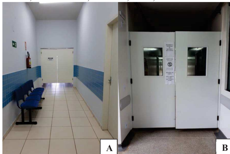
Figura 23 - Portas do tipo vaivém, A – ESF Cosmos, B – UPA II, Toledo, PR.
