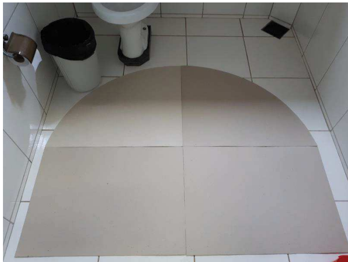
Figura 27 - Sanitário acessível: Possibilidade de rotação em 180°, ESF Jardim Pancera, Toledo – PR.
