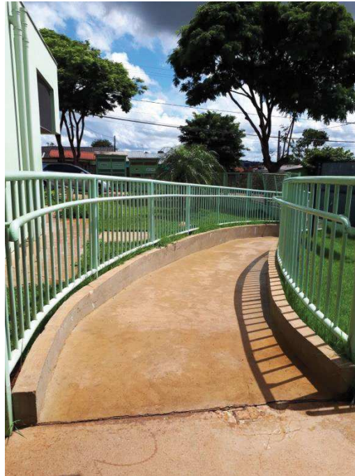
Figura 16 – Rampa de acesso da ESF do Jardim Europa, Toledo - PR.
