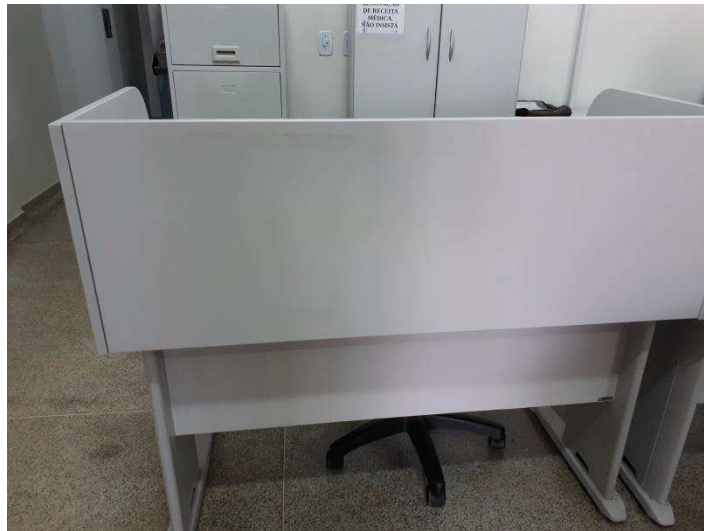
Figura 20 – Balcão de atendimento não acessível, UPA II, Toledo – PR.
