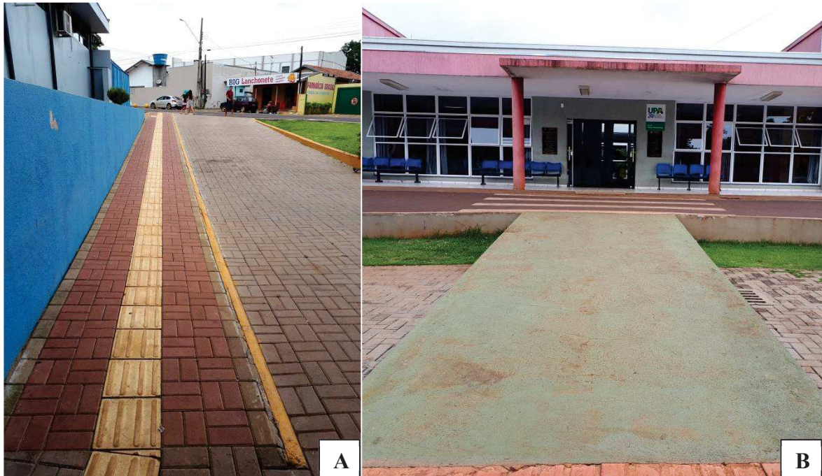
Figura 17 – Áreas de acesso à edificação, A – Rampa de acesso da UPA II, B – Rampa de acesso da UPA I, Toledo – PR.
