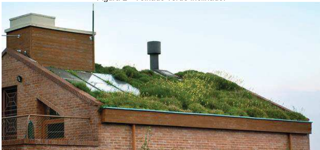
Figura 2 - Telhado verde inclinado.
