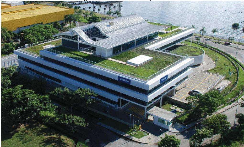
Figura 1 - Telhado verde plano.
