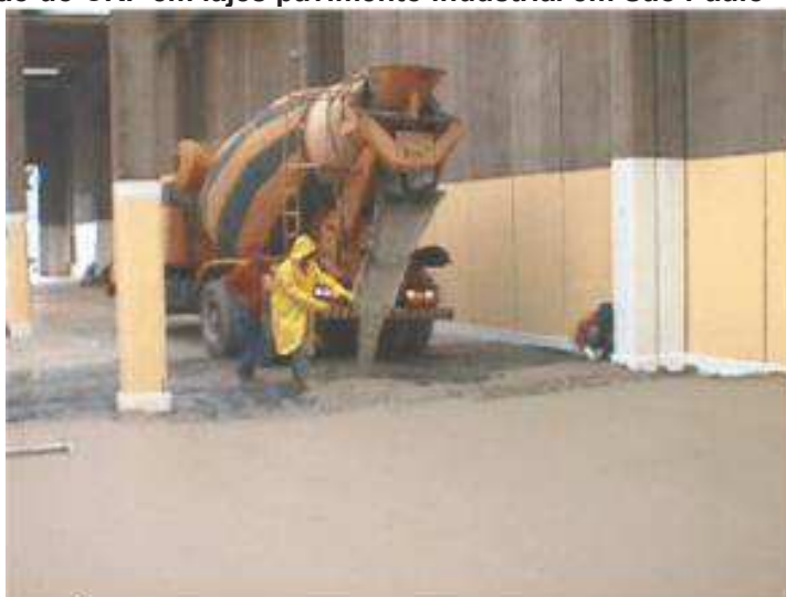
Figura 11 - Aplicação do CRF em lajes pavimento industrial em São Paulo
