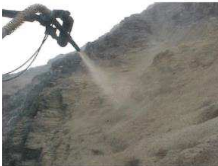
Figura 12 - Aplicação do CRF em lajes revestimento de talude em Minas Gerais
