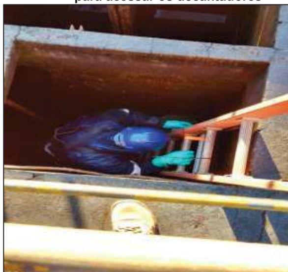
Figura 14 – Funcionário adentrando as chicanas para acessar os decantadores
