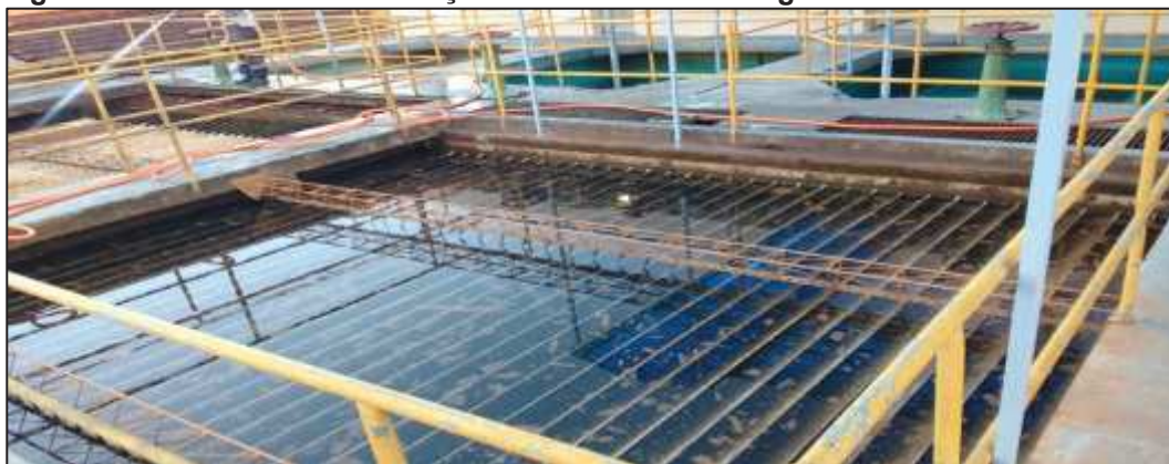
Figura 12 – Decantador da Estação de Tratamento de Água analisada
