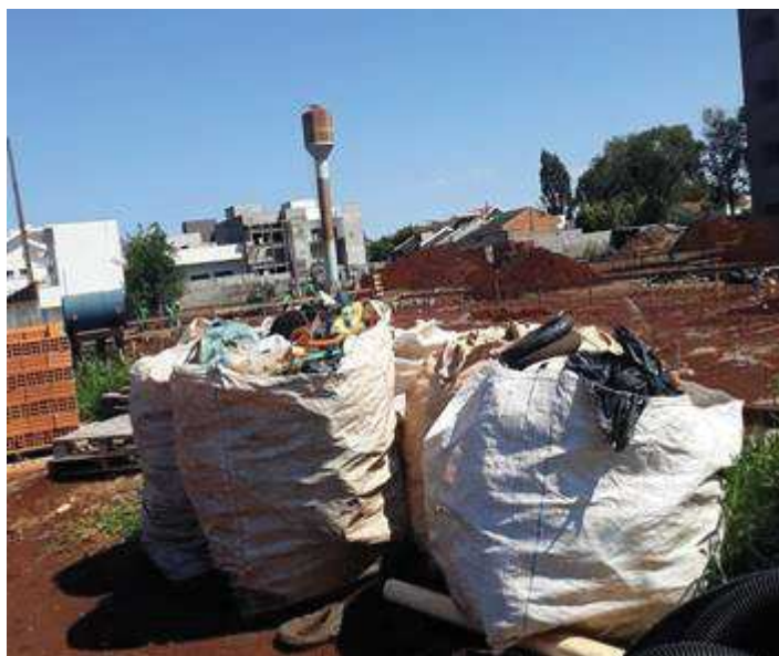
Figura 11 - Acondicionamento de RCCs classe B da empresa B
