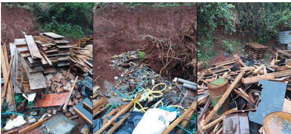
Figura 10 - Disposição dos RCCs no canteiro de obra da empresa A
