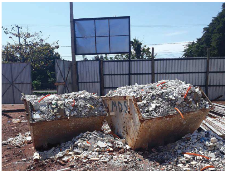
Figura 14 - Disposição de resíduos em caçambas metálicas
