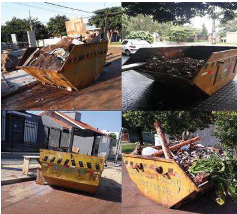
Figura 25 - Caçambas metálicas utilizadas no transporte de RCCs no município de Toledo-PR
