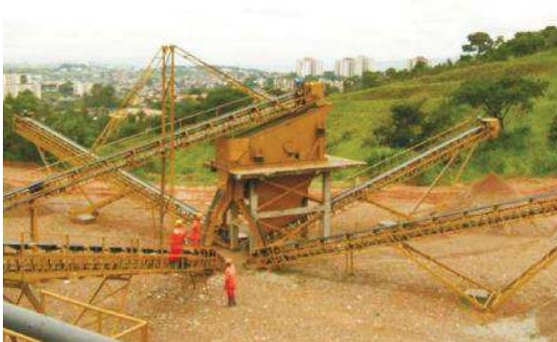
Figura 6 - Estação de Reciclagem da Pampulha, em Belo Horizonte - MG
