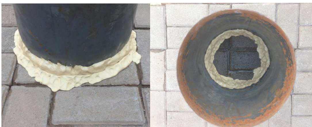
Figura 13 – Instalação do anel cilíndrico Fonte: Autor (2017)
