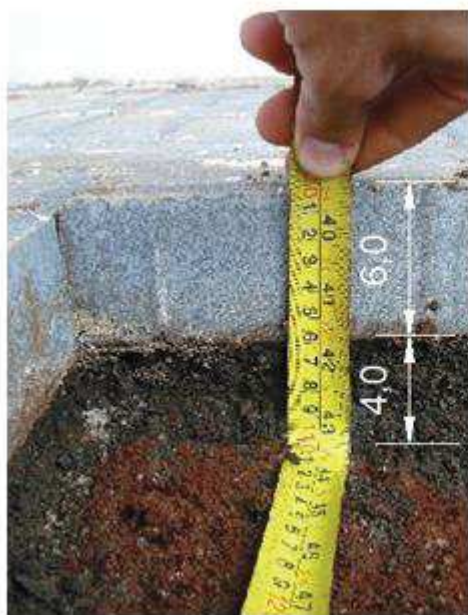
Figura 2 – Seção de um pavimento permeável comumente executado Fonte: Martins (2014, p.42)
