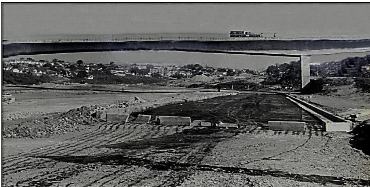
Figura 9 - Construção Avenida Teotônio Vilela Fonte: São José dos Campos de Antigamente
