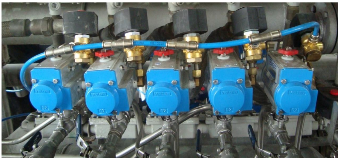
Fotografia 10 - Posicionamento dos equipamentos
