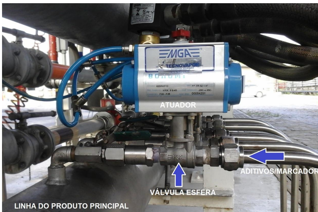
Fotografia 9 - Instalação dos equipamentos novo projeto
