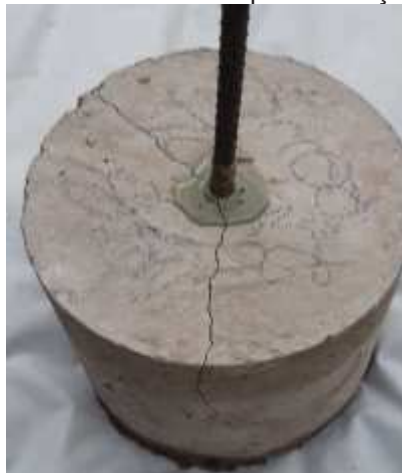
Figura 50 – Fissuras causadas pela formação da cunha
