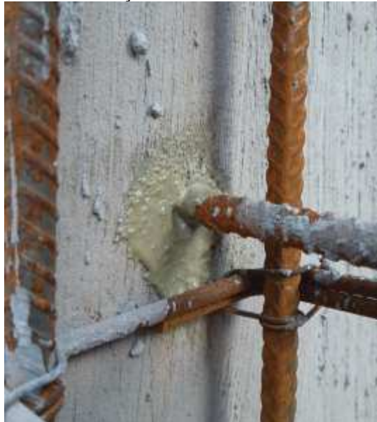
Figura 01 – Barra de aço colado ao concreto com resina epóxi
