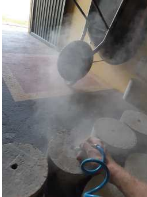
Figura 40 – Limpeza do orifício com ar comprimido
