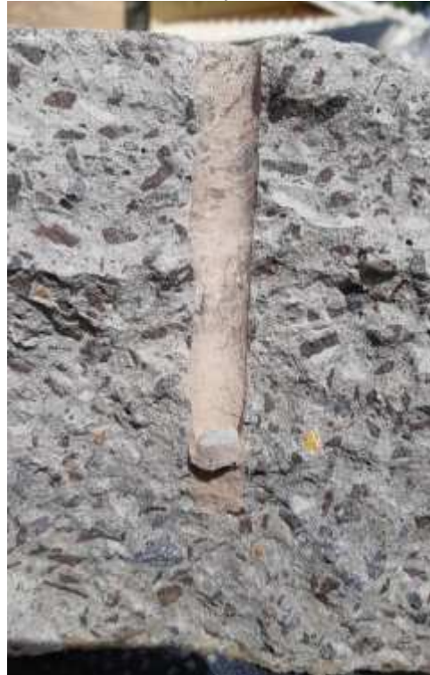
Figura 53 – Orifício no concreto após a abertura do corpo de prova
