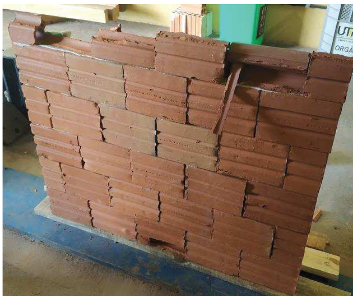
Figura 14 - Fissuração típica protótipo com argamassa polimérica apenas na horizontal
