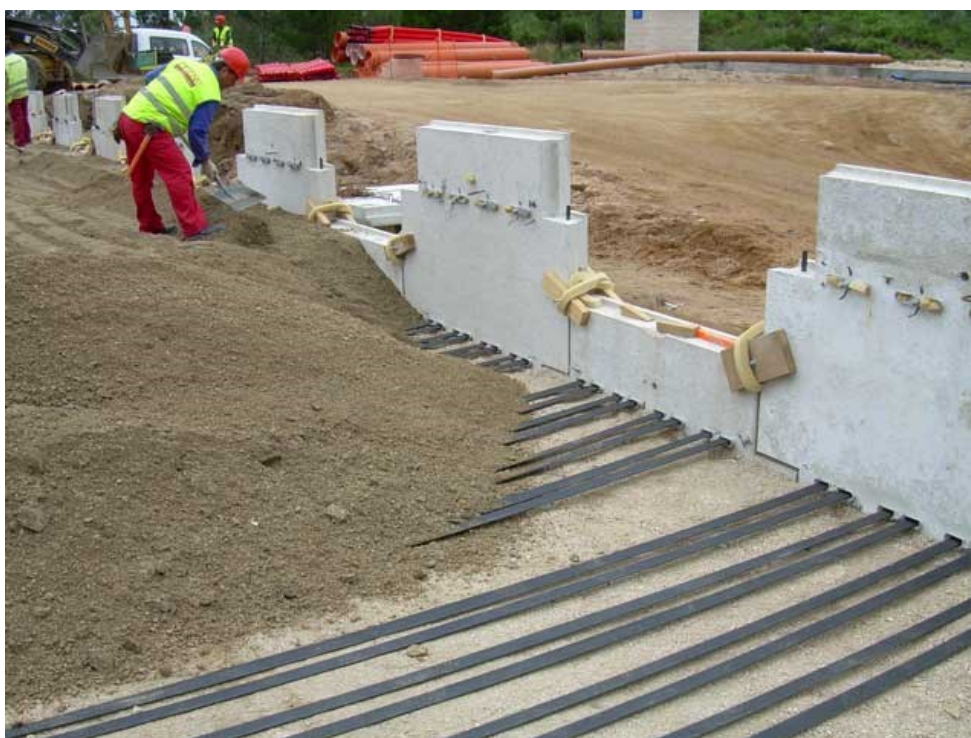
Figura 5 – Reforços metálicos fixados às escamas.
