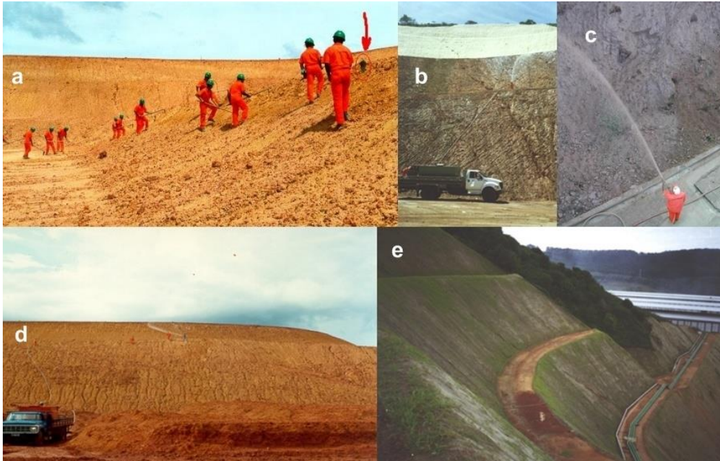
Figura 22 - Passo a passo: Hidrossemeadura
