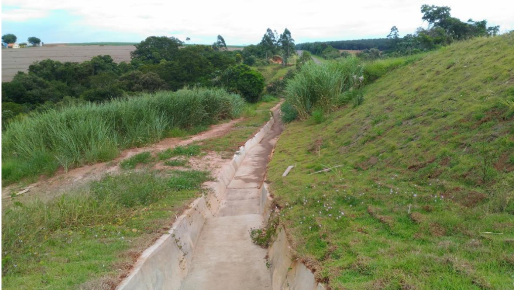
Figura 28 - Soluções implantadas nas erosões (Lado Direito, KM 150+480)
