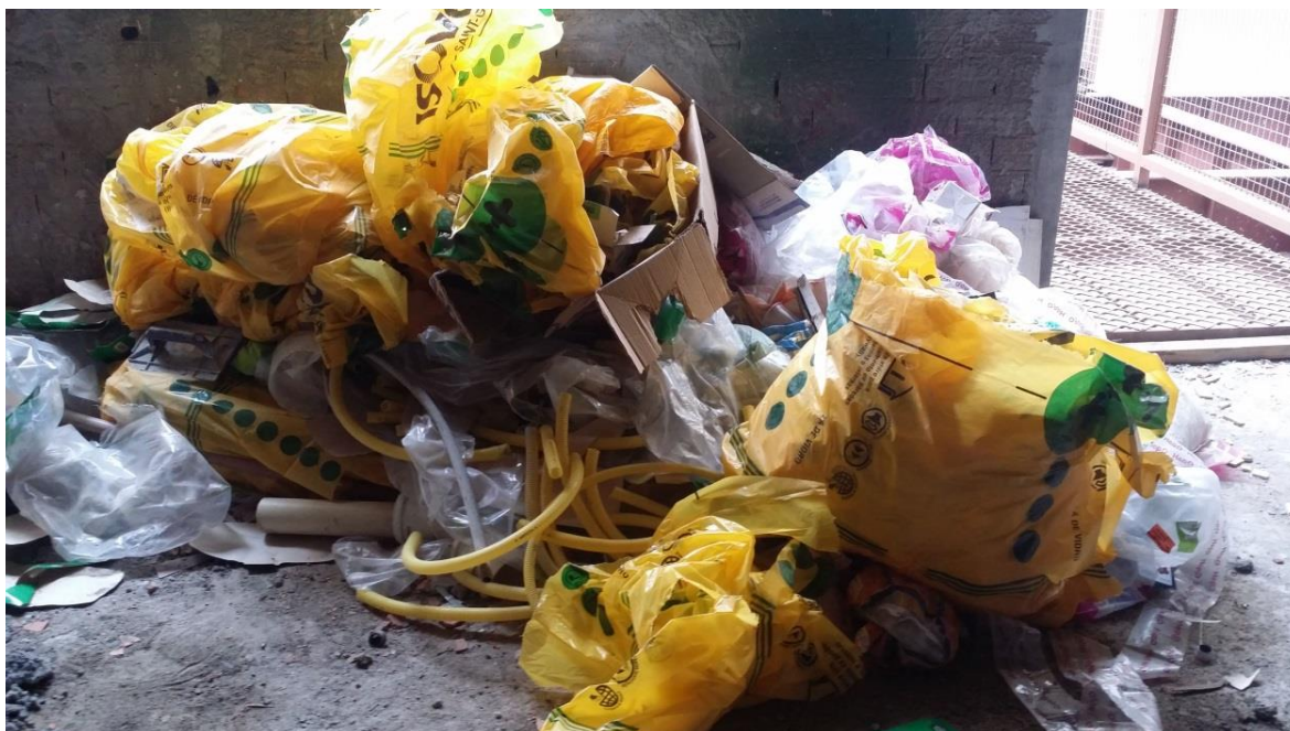
Figura 8 – Restos de materiais segregados de forma incorreta.
