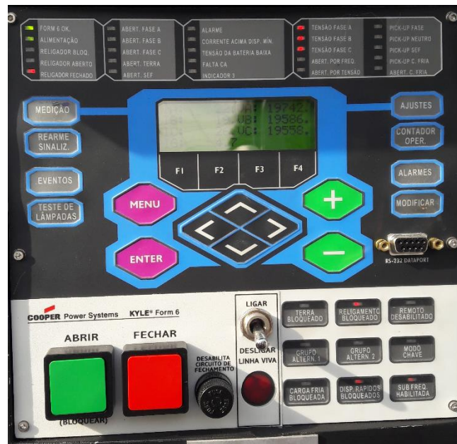
Figura 9 – Controle eletrônico do religador Fonte: Autoria própria
