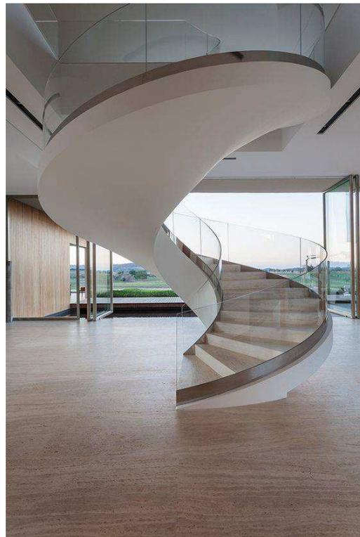
**Figura 1 – Escada helicoidal com viga em concreto armado, degraus em concreto e corrimão misto de vidro e inox**
