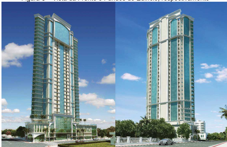
Figura 6 – Vista da Frente e Fundos do Edifício, respectivamente
