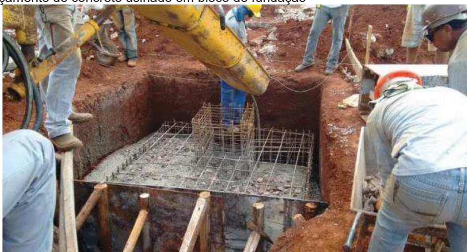
Figura 12 - Lançamento de concreto usinado em bloco de fundação
