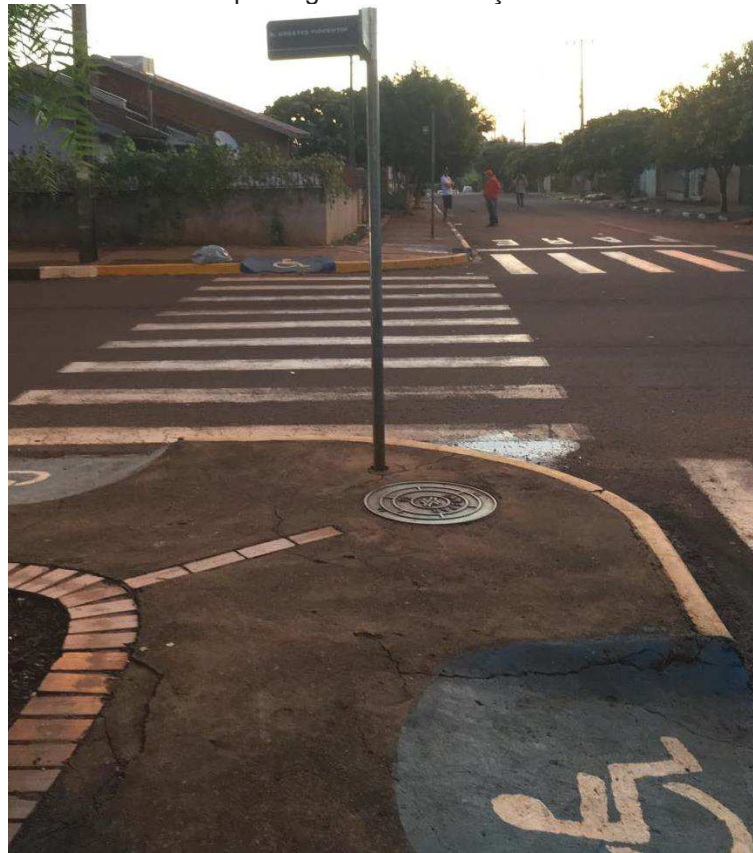
Figura 12 - Foto da calçada do mostrando a faixa de acesso para cadeirante inadequada e poste de passagem sem indicação
