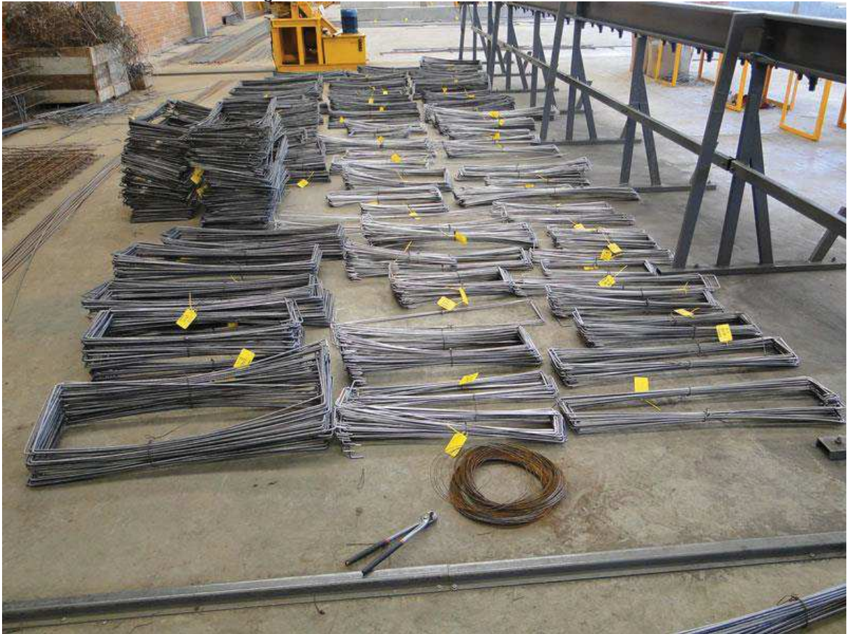
Figura 1 – Armaduras cortadas e dobradas
