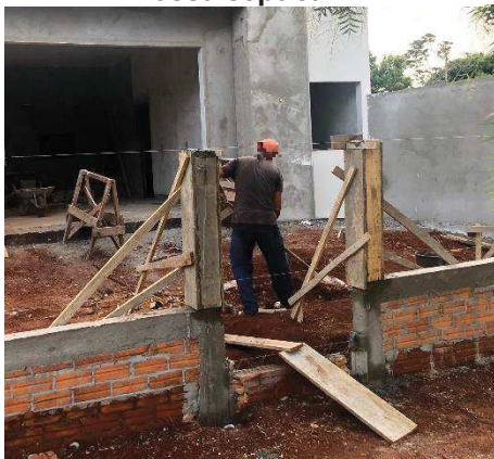
Figura 47 – Funcionário escavando fossa séptica.
