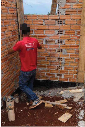
Figura 59 – Funcionário retirando as fôrmas.
