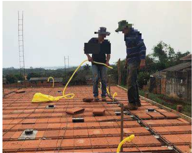
Figura 36 – Funcionários passando dutos de eletricidade.
