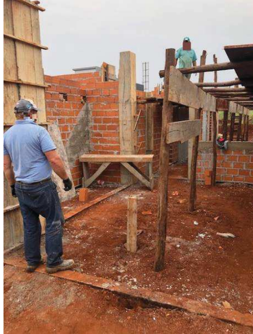
Figura 39 – Funcionários trabalhando na obra H.
