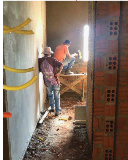
Figura 53 – Funcionários rebocando parede.
