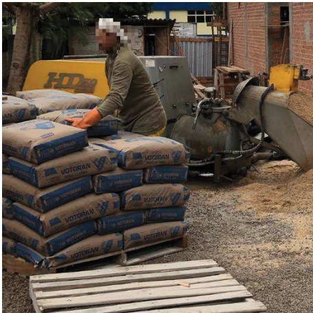
Figura 23 – Funcionário carregando cimento.
