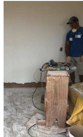
Figura 45 – Funcionário trabalhando obra K.
