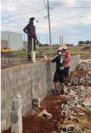
Figura 64 – Funcionários trabalhando obra T.
