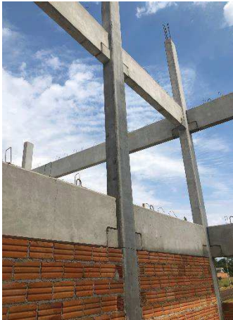
Figura 40 – Estrutura pré-moldada com alvenaria convencional.
