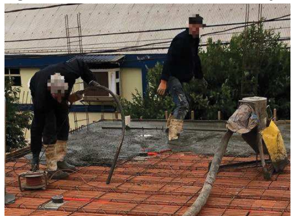
Figura 24 – Funcionários concretando a laje.
