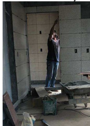
Figura 48 – Funcionário assentando azulejo.
