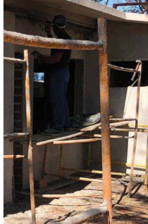
Figura 26 – Funcionário fazendo requadrção da viga.
