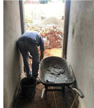
Figura 51 – Funcionário requadrando as aberturas.
