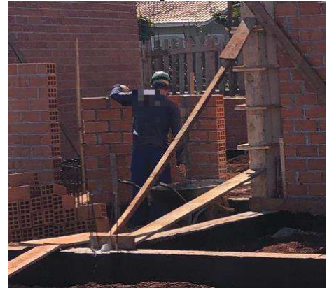
Figura 28 – Funcionário assentando tijolo.
