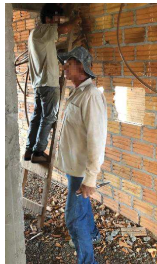
Figura 57 – Funcionário trabalhando obra P.
