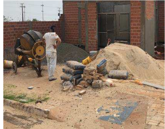
Figura 38 – Funcionário produzindo concreto.
