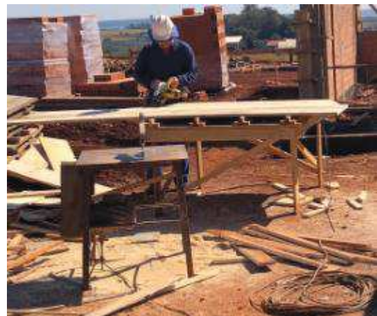
Figura 30 – Operário manuseando serra circular.
