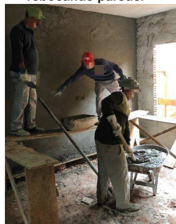
Figura 22 – Funcionários rebocando parede.
