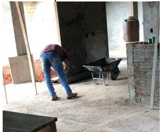
Figura 63 – Funcionário rebocando parede interna.
