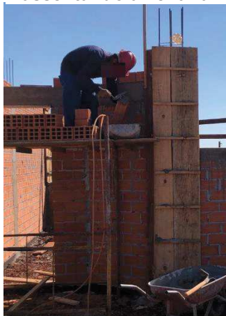
Figura 29 – Funcionário assentando alvenaria.
