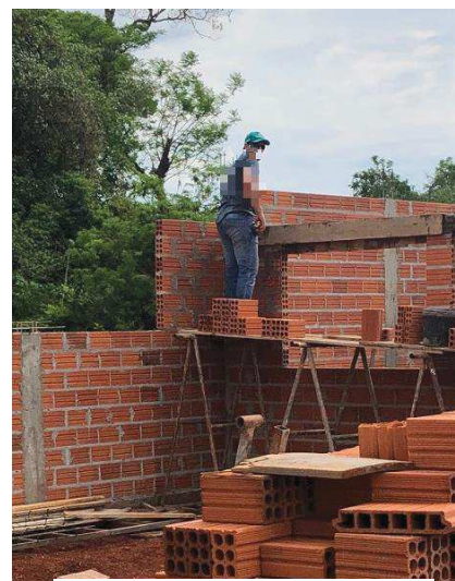
Figura 55 – Funcionário assentando alvenaria obra O.
