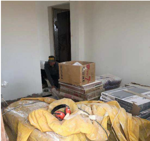
Figura 44 – Funcionário assentando piso.
