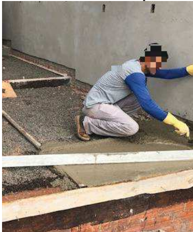
Figura 37 – Funcionário executando o contrapiso.
