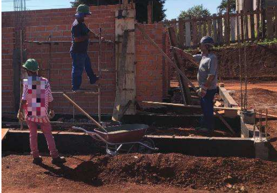
Figura 27 – Funcionários concretando pilar.
