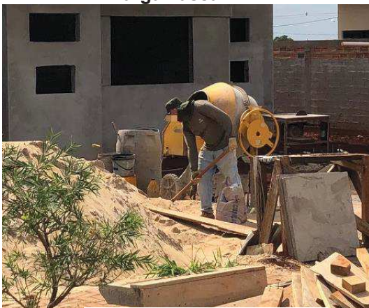
Figura 62 – Funcionário produzindo argamassa.
