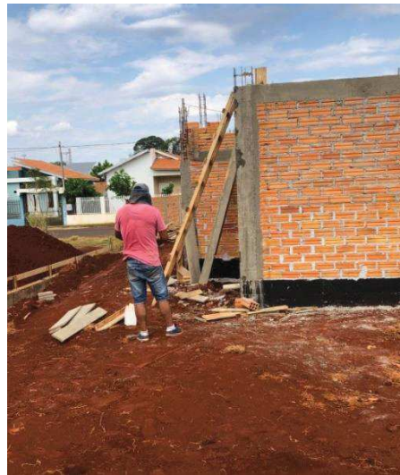
Figura 60 – Funcionário trabalhando obra Q.
