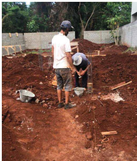
Figura 61 – Funcionários executando alicerce.
