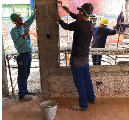
Figura 25 – Funcionários trabalhando na obra B.
