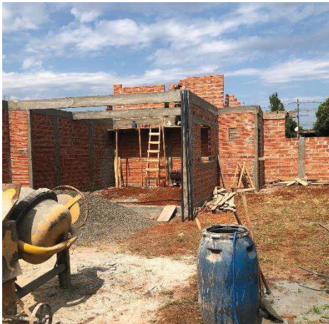
Figura 42 – Obra em construção.
