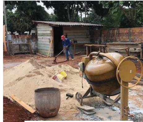
Figura 34 – Funcionário fazendo corte das ferragens.
