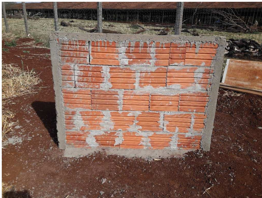
Figura 39 – Elevação em alvenaria convencional.
