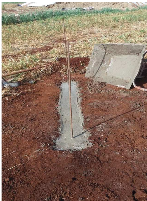
Figura 36 – Fundação para construção de estrutura em alvenaria.
