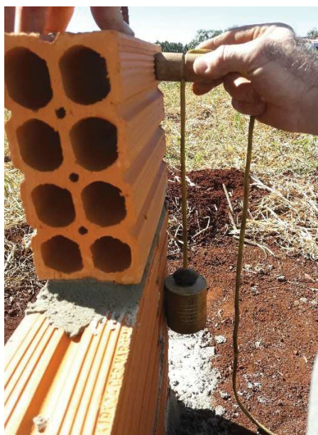
Figura 38 – Verificação de verticalidade com o prumo.
