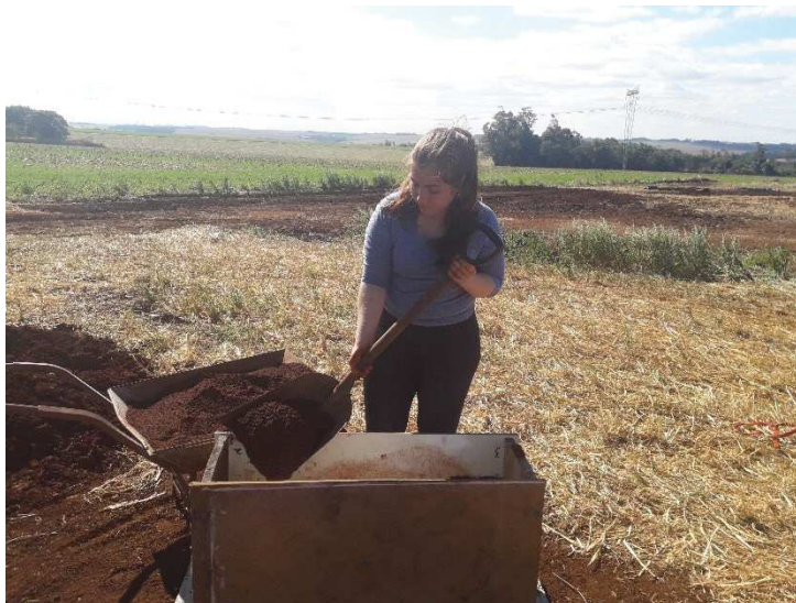
Figura 31 – Produção de estrutura em taipa de pilão.
