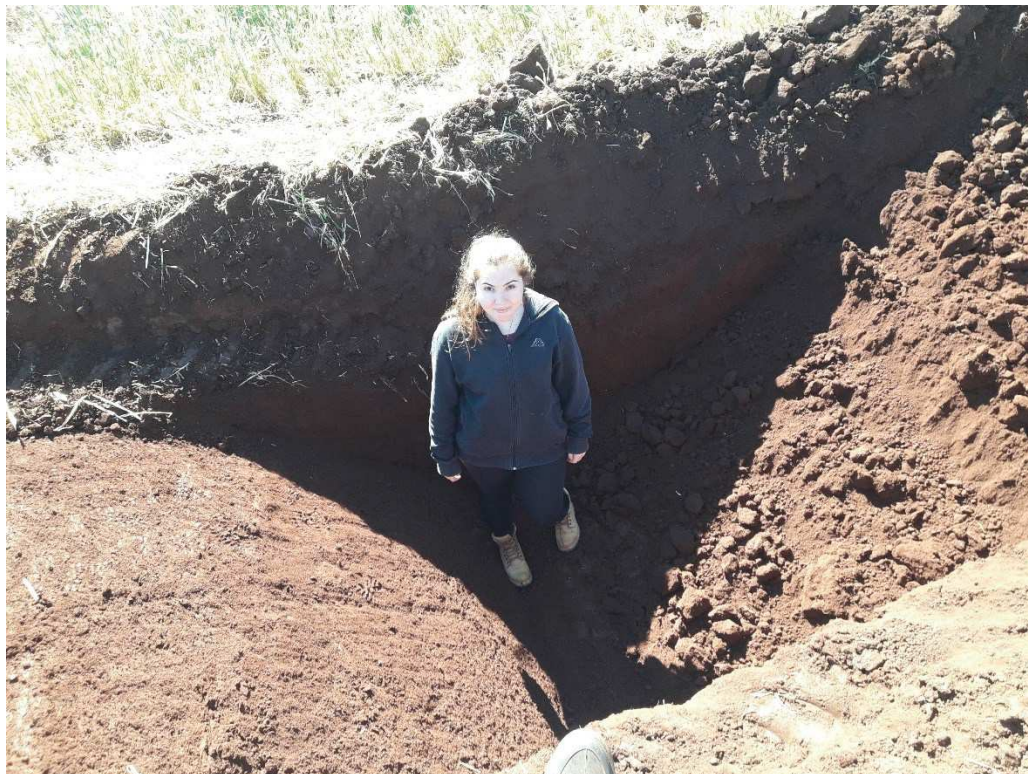
Figura 25 – Profundidade de escavação para utilização de solo.
