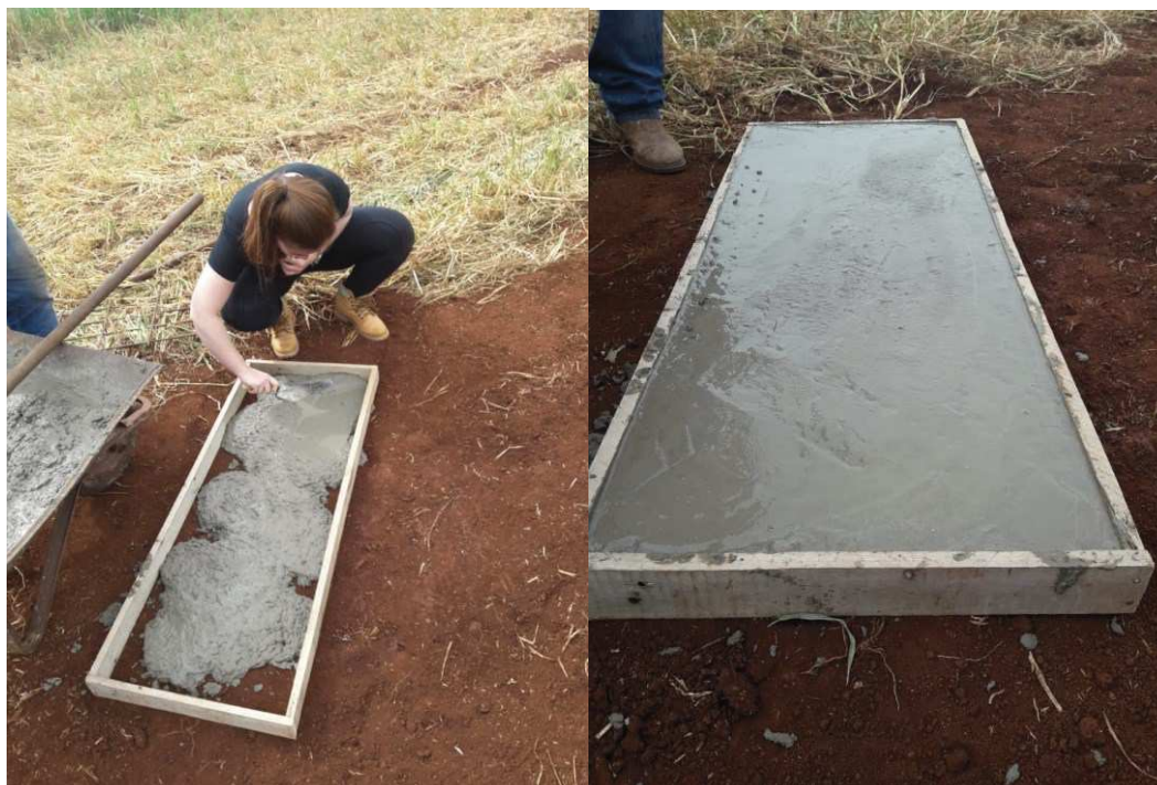
Figura 29 – Confeção de base para elevação em taipa.
