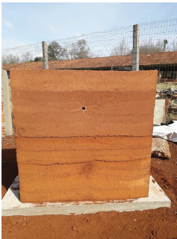
Figura 34 – Elevação em taipa de pilão.
