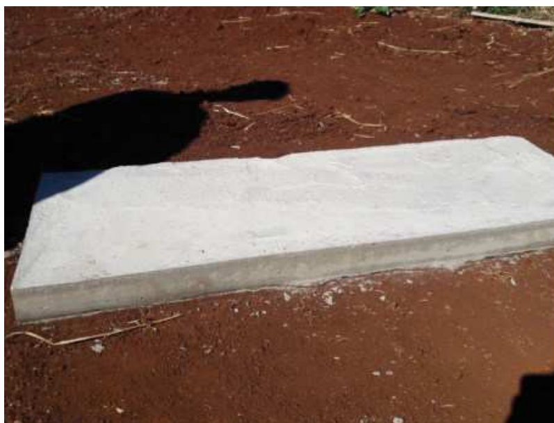
Figura 30 – Fundação para confecção de elevação em taipa.
