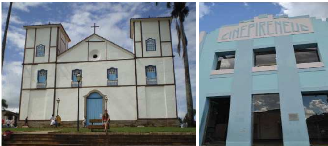
Figura 9 – Exemplos de uso em taipa de pilão em Goiás.
