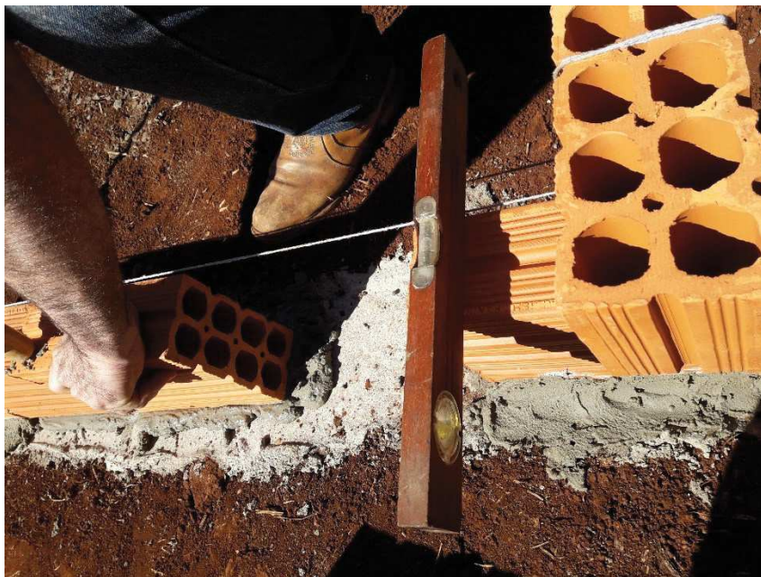
Figura 37 – Verificação de nível.
