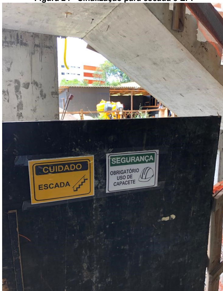
Figura 24 - Sinalização para escada e EPI
