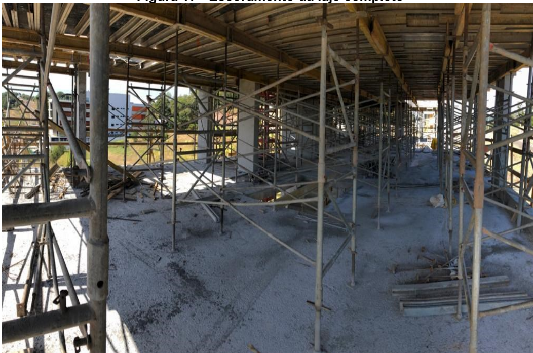
Figura 17 - Escoramento da laje completo
