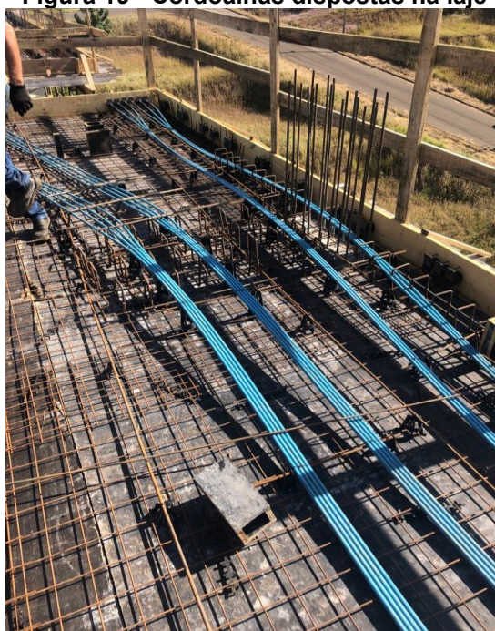
Figura 19 - Cordoalhas dispostas na laje
