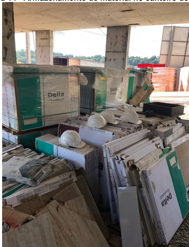
Figura 14 - Armazenamento de material no canteiro de obras
