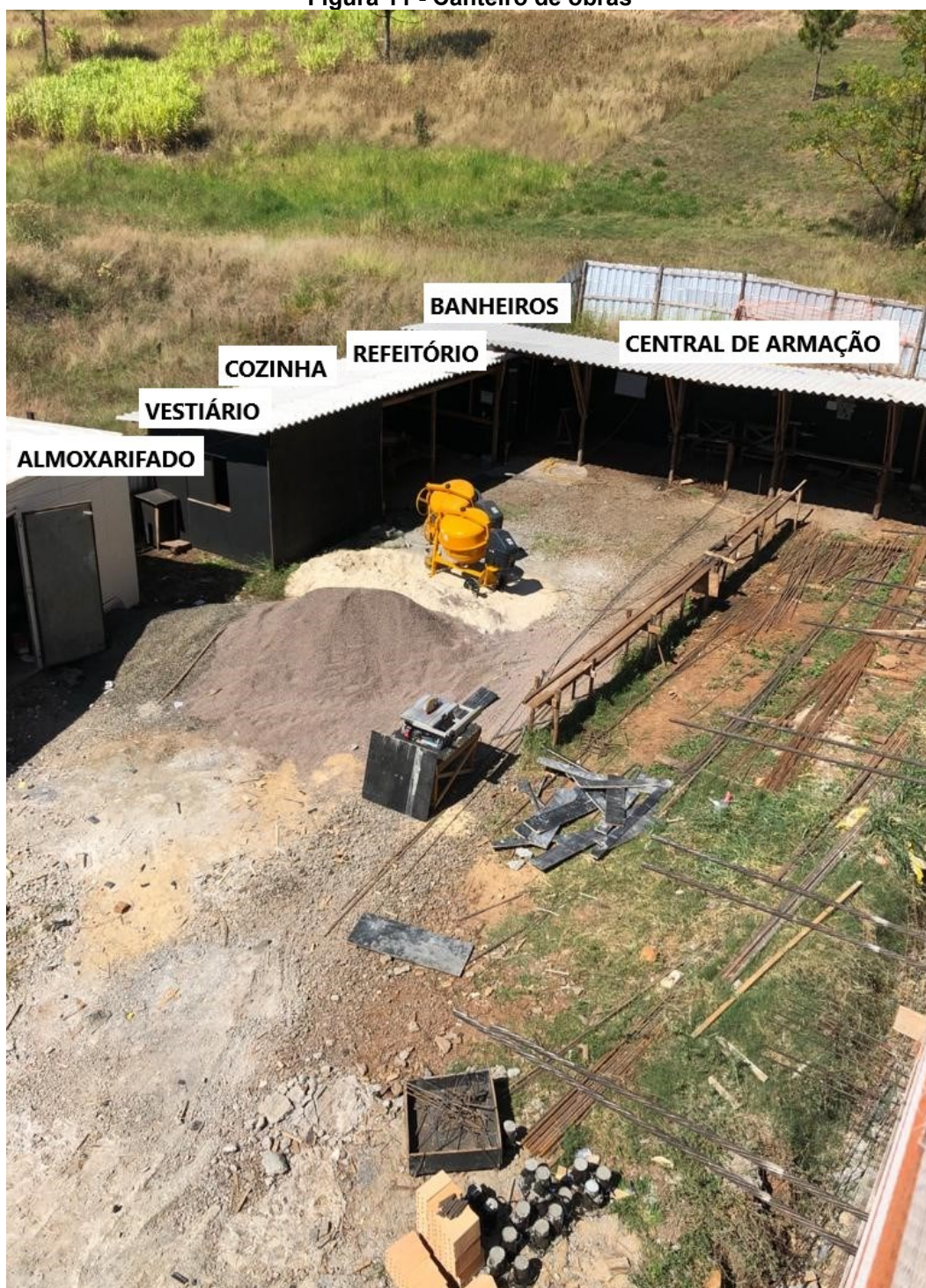
Figura 11 - Canteiro de obras
