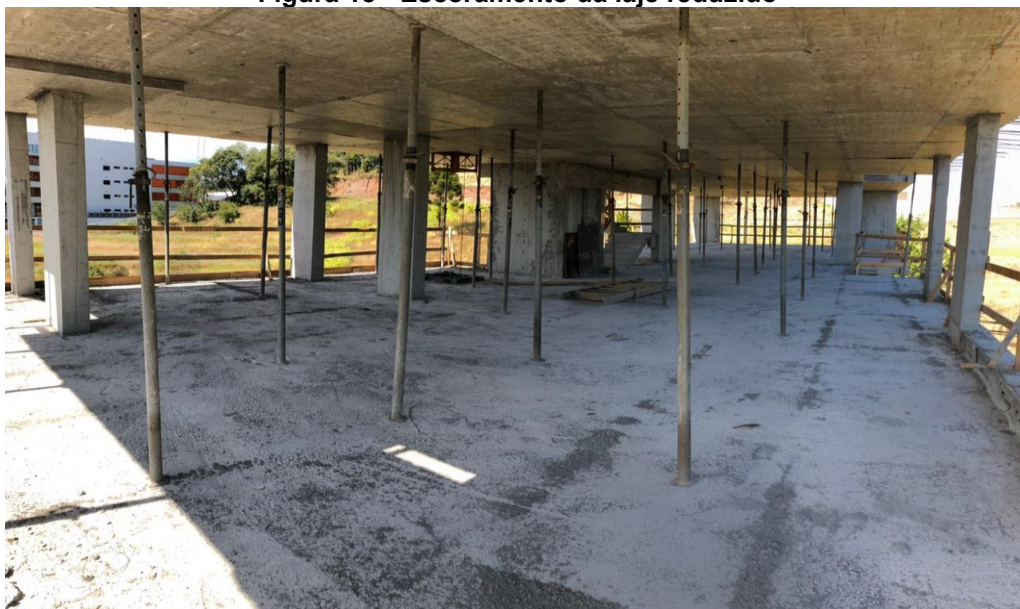
Figura 18 - Escoramento da laje reduzido
