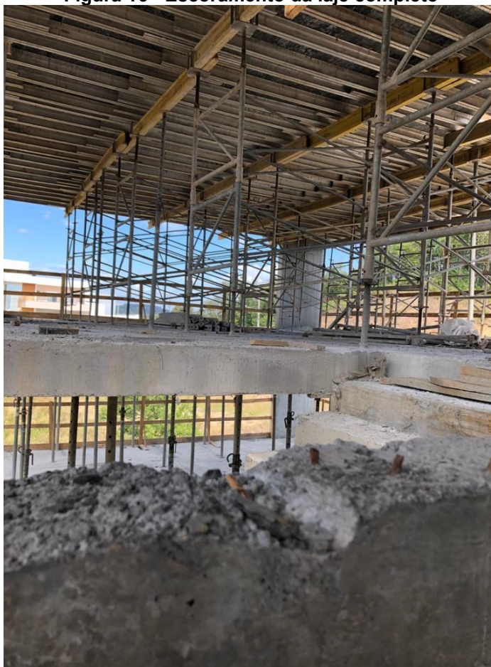
Figura 16 - Escoramento da laje completo
