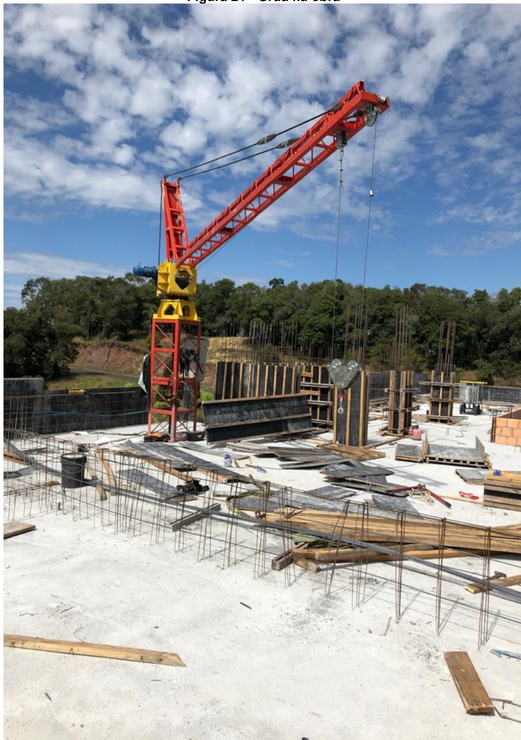
Figura 21 - Grua na obra
