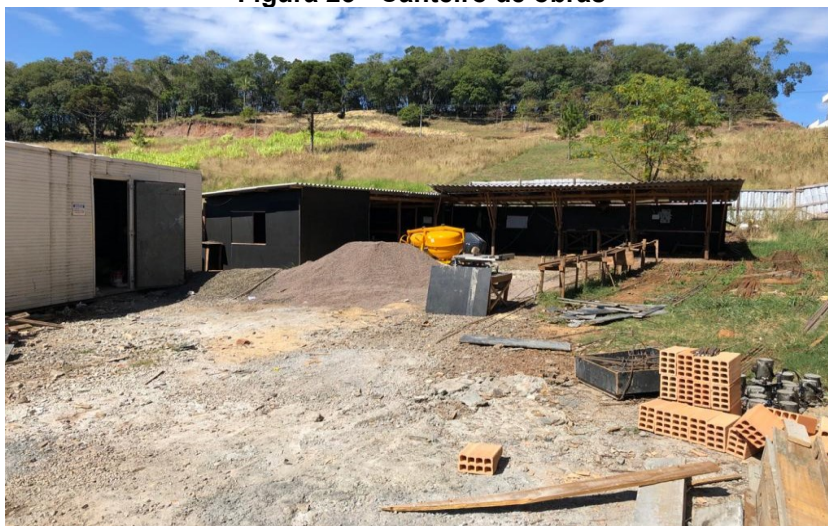
Figura 23 - Canteiro de obras
