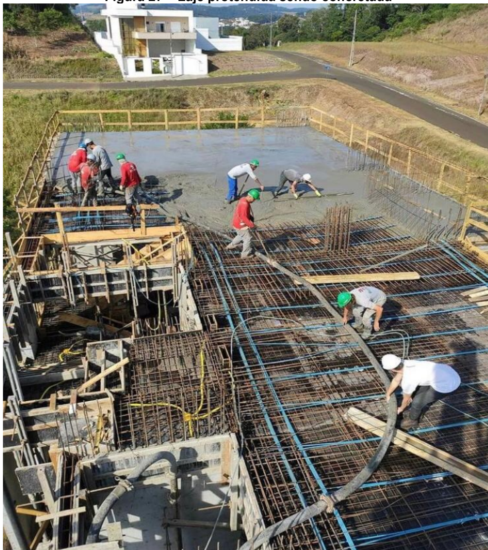
Figura 27 – Laje protendida sendo concretada
