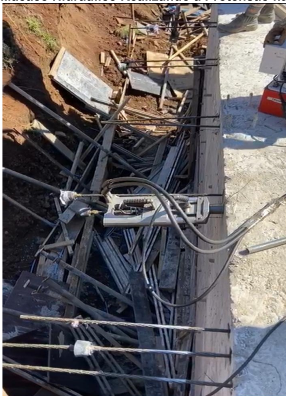
Figura 6 - Macaco Hidráulico Realizando a Protensão na Cordoalha
