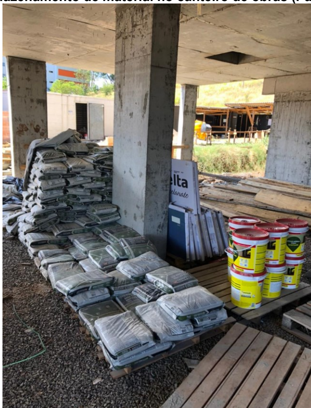
Figura 13 - Armazenamento de material no canteiro de obras (Pavimento Térreo)
