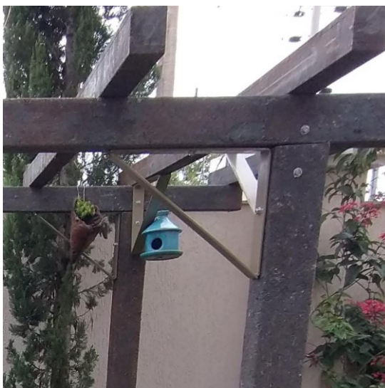
Figura 24 - Ligação em mão francesa metálica
