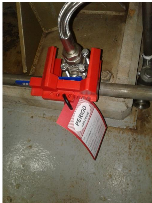
Figura 3: Bloqueio de válvula esférica Fonte: Autor
