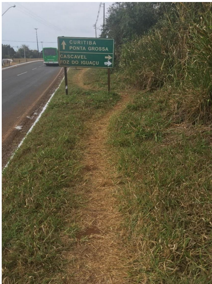
Figura 11. Trilha formada pelos pedestres devido à falta de pavimentação
