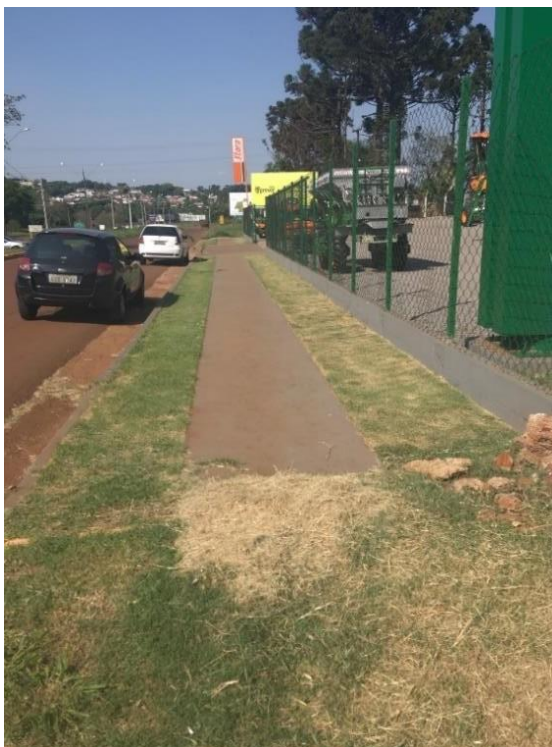
Figura 21. Trecho da Rua Rosalina Maria Ferreira pavimentado conforme padrão C
