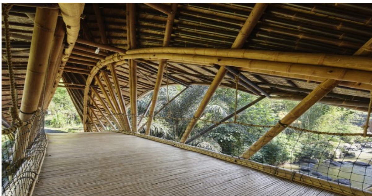
Figura 11 – Arcos da passarela Millenium Bridge em Bali, Indonésia.
