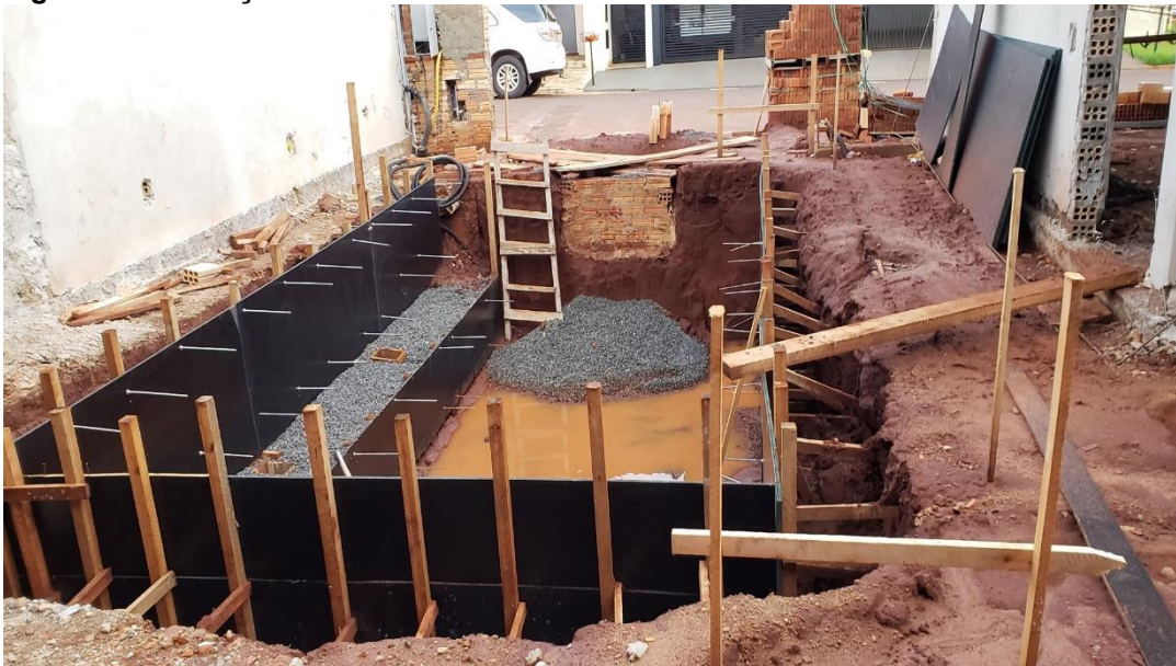
Figura 11 – Situação da obra dia 15/01/2019
