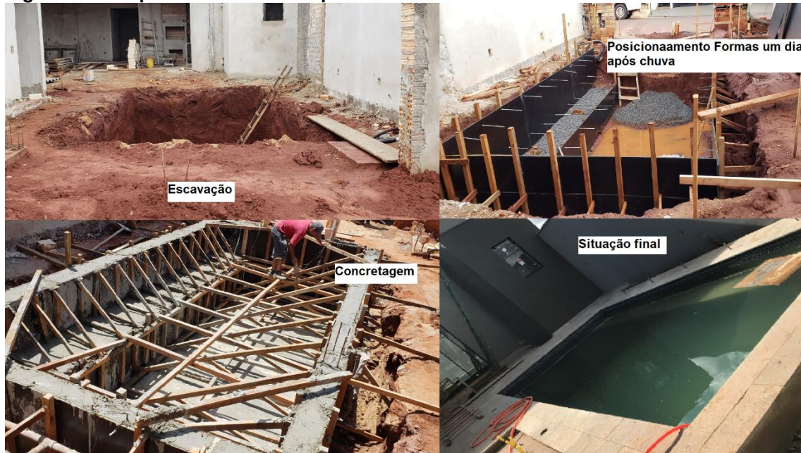
Figura 13 – Etapas construtivas da piscina
