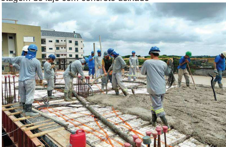
Figura 19 - Concretagem de laje com concreto usinado
