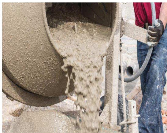
Figura 5 - Concreto executado em obra
