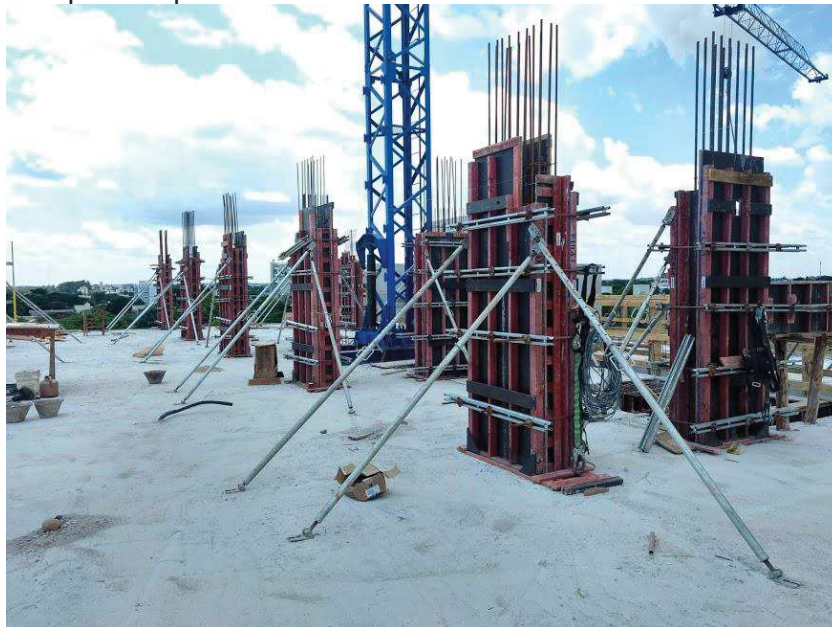
Figura 20 - Pilares prontos para serem concretados
