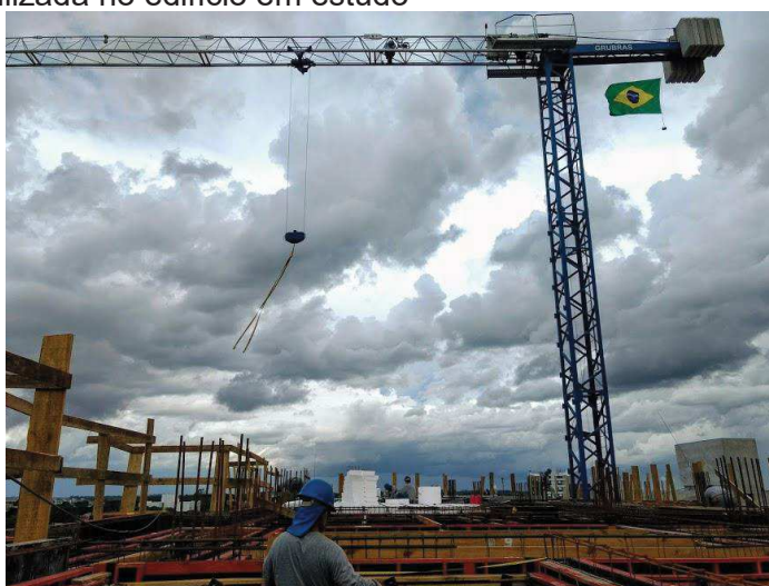
Figura 11 - Grua utilizada no edifício em estudo
