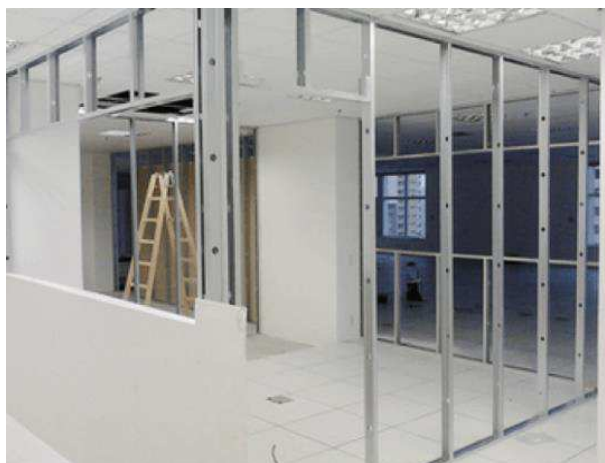
Figura 6 - Divisórias em Dry Wall
