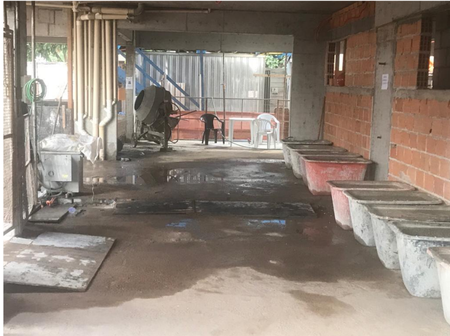
Fotografia 7 – Armazenamento de caixas com argamassa estabilizada
