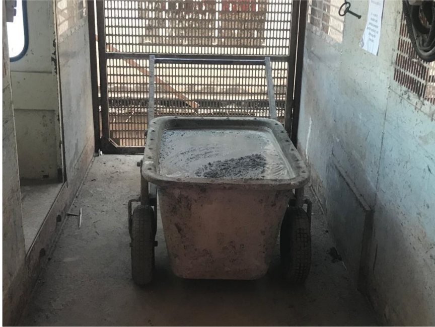
Fotografia 8 – Carrinho para transporte de argamassa estabilizada
