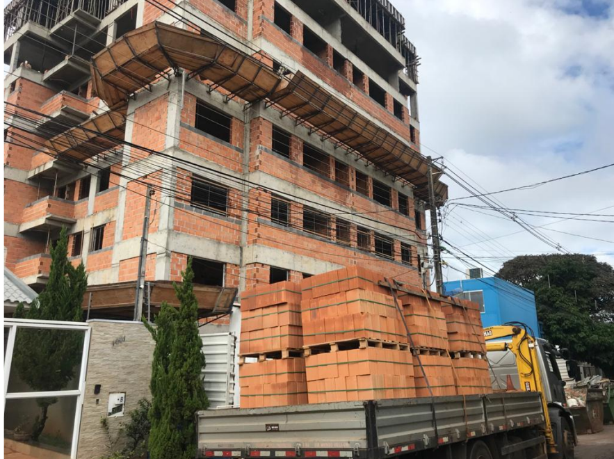
Fotografia 9 – Abastecimento do canteiro de obras
