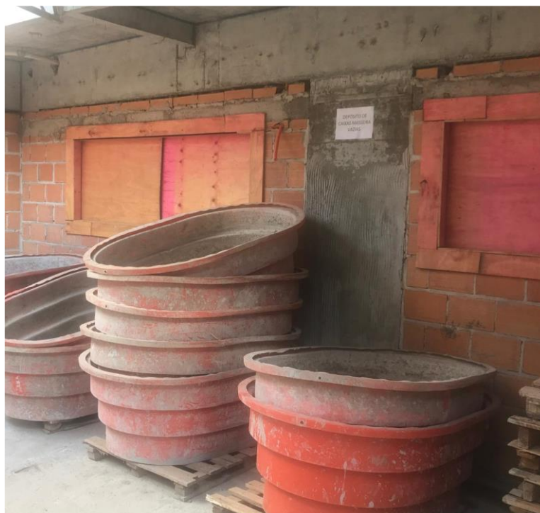
Fotografia 15 – Armazenamento das caixas de argamassa estabilizada
