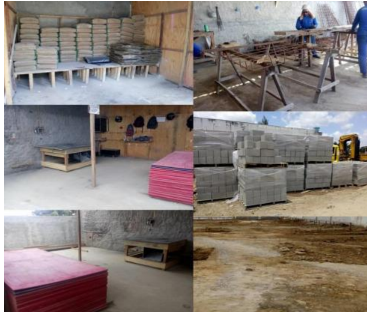
Fotografia 2: Implantação de 5S no canteiro de obras
