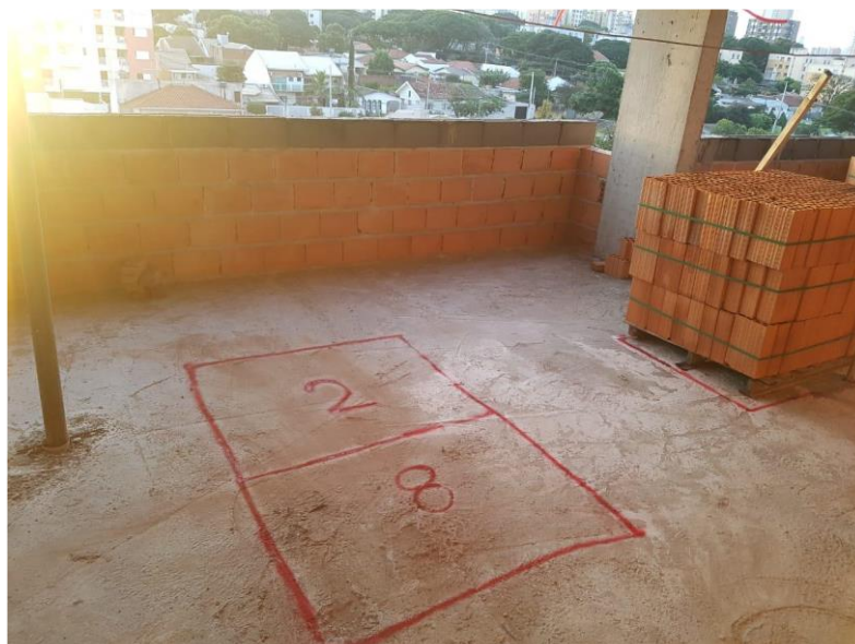
Fotografia 12 – Armazenamento dos pallets de bloco cerâmico no pavimento
