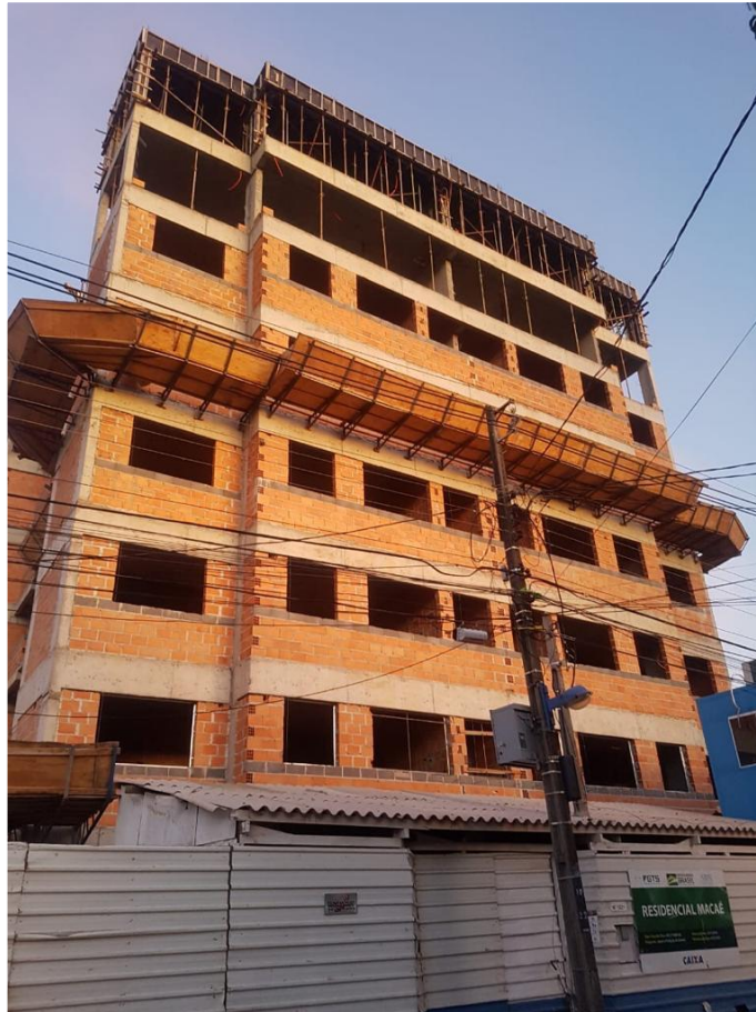
Fotografia 13 – Fachada do empreendimento em construção
