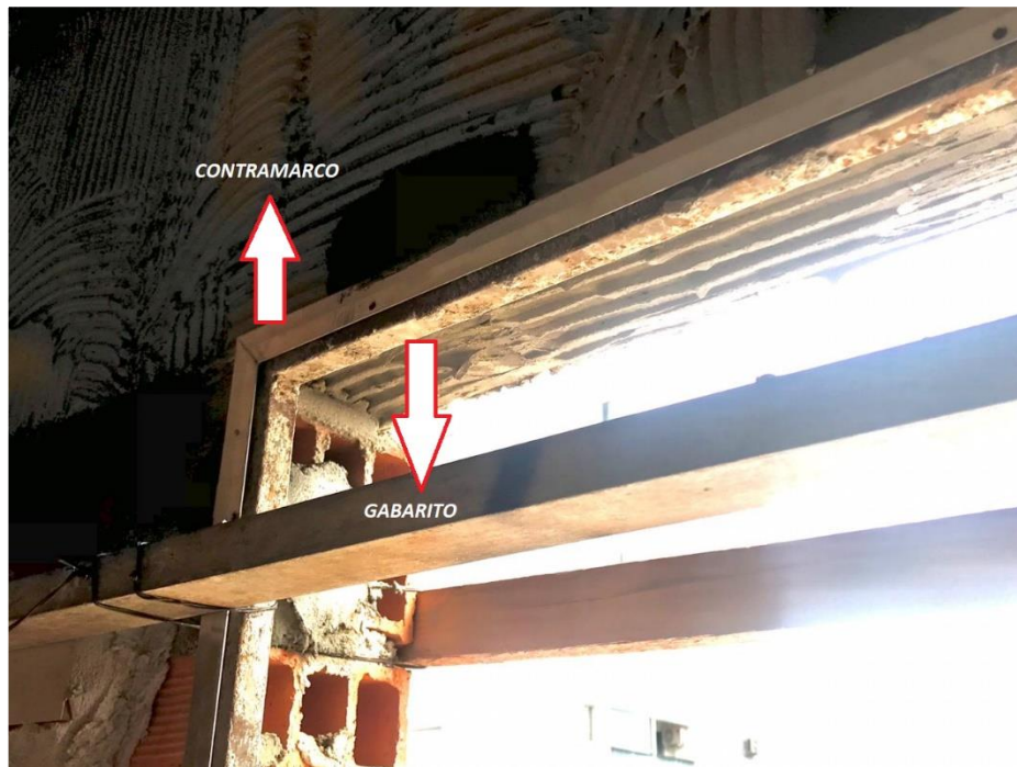
Fotografia 19 – Gabarito metálico na instalação do contramarco
