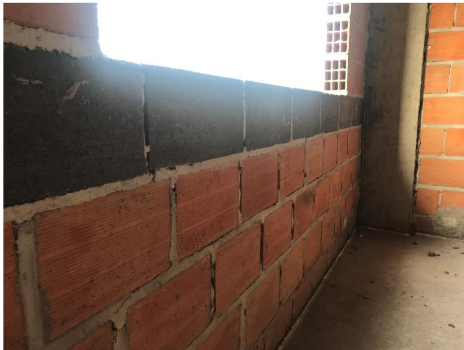
Fotografia 6 – Bloco canaleta de concreto utilizado na contra verga
