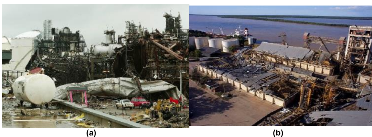
Figura 14: Danos causados por explosão de poeira.
