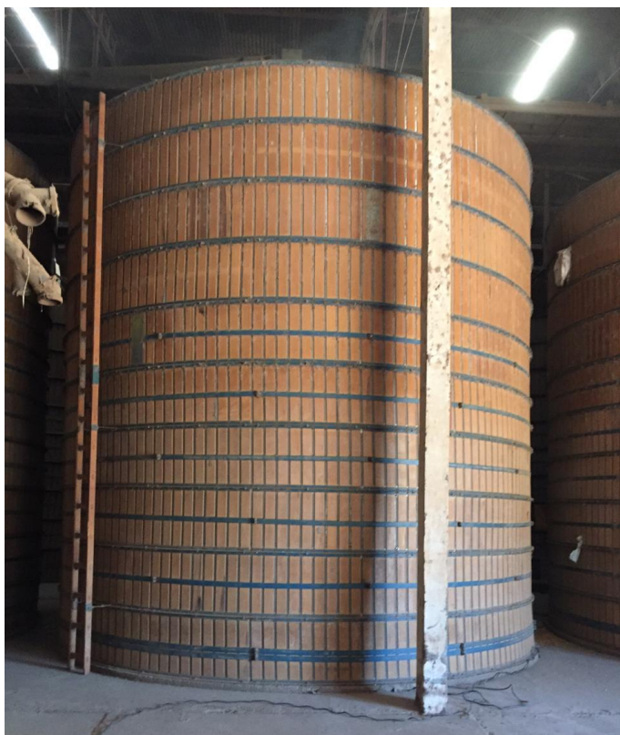
Figura 28: Silo de armazenamento unidade B.
