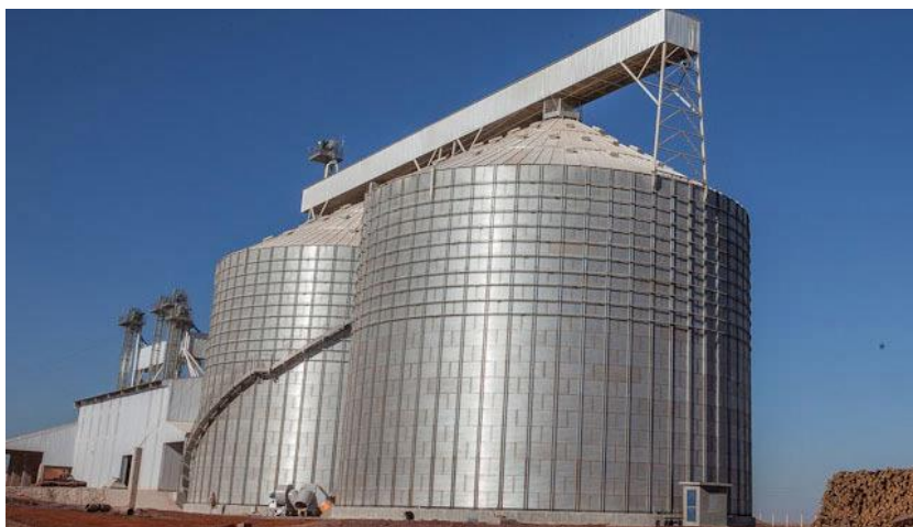
Figura 4: Silo de armazenamento.
