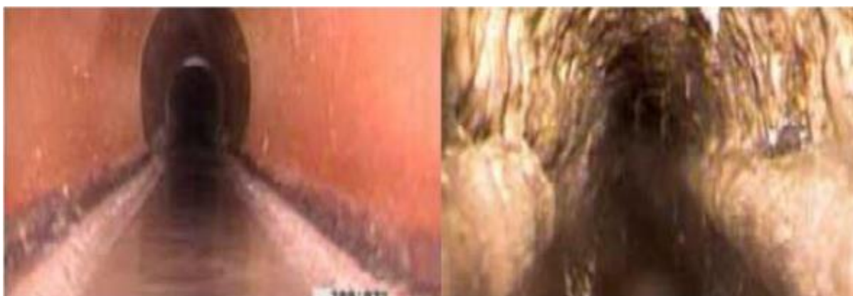
Figura 2 – Fotos de uma tubulação, antes e depois do contato com o óleo. Fonte: SF GreaseCycleProgram (2007).
