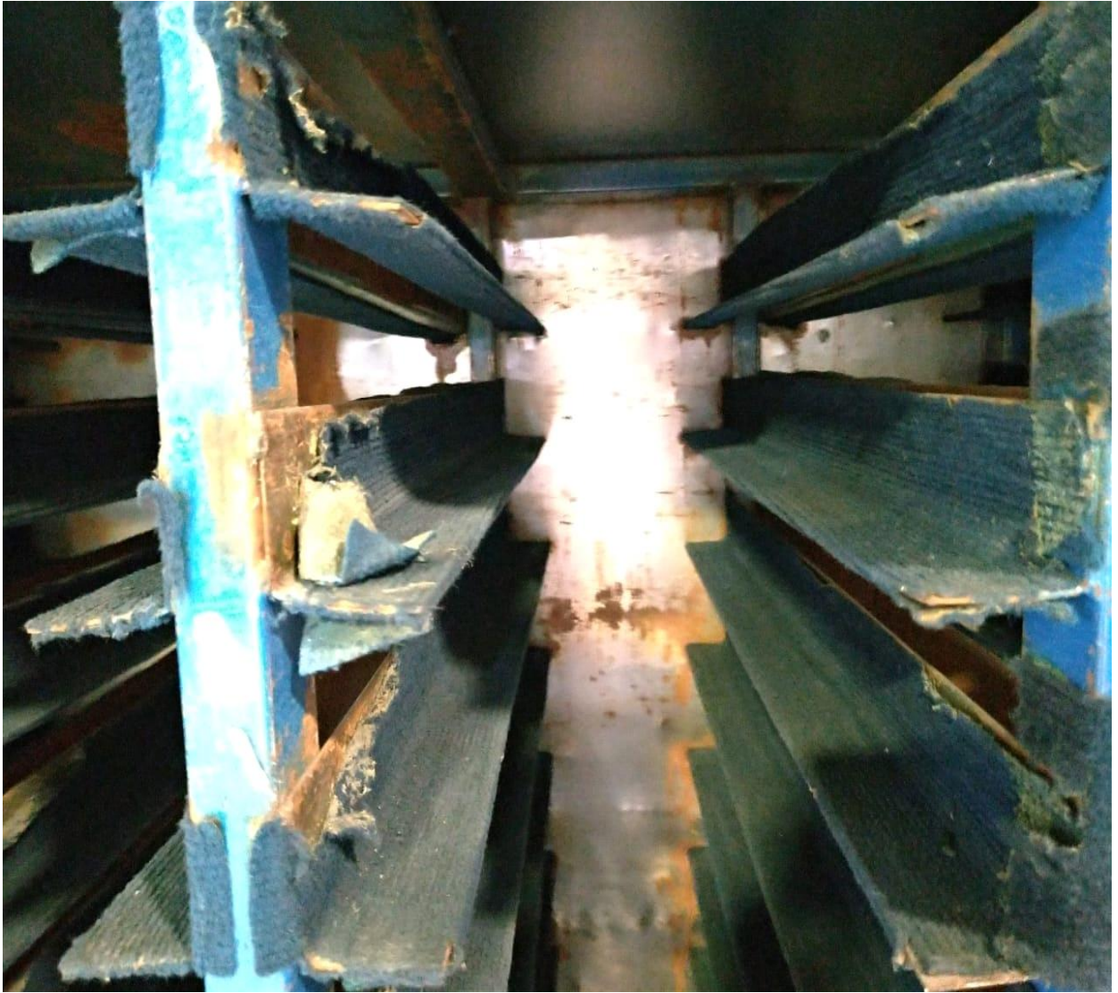
Figura 8 – Exemplo de local de estoque danificado
