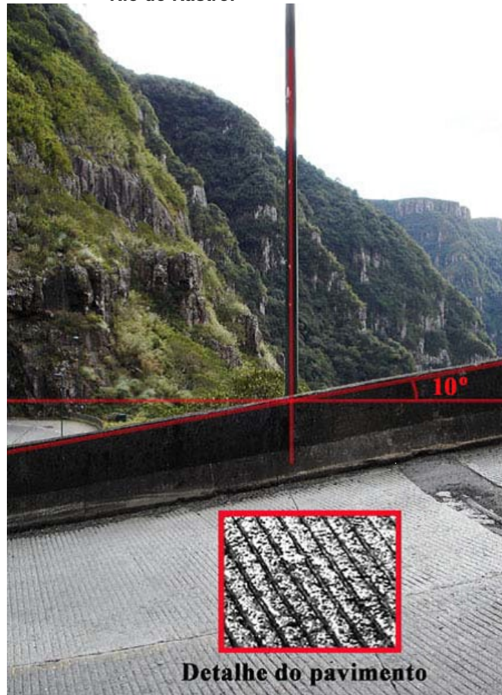
Figura 29 – Rampa com inclinação excepcionalmente grande (10º ou 18 Rodovia SC 480 na Serra do Rio do Rastro.
